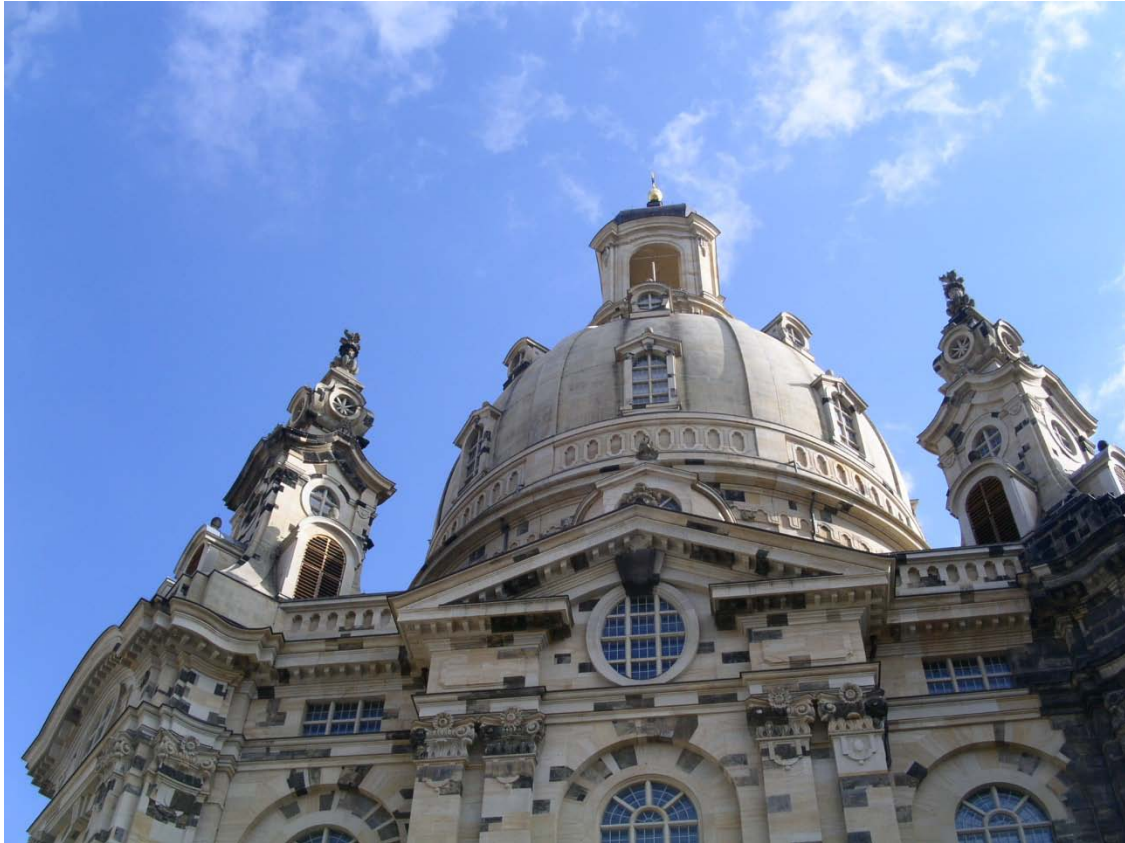
Figur 17: Fordeling av nye og gamle stener
