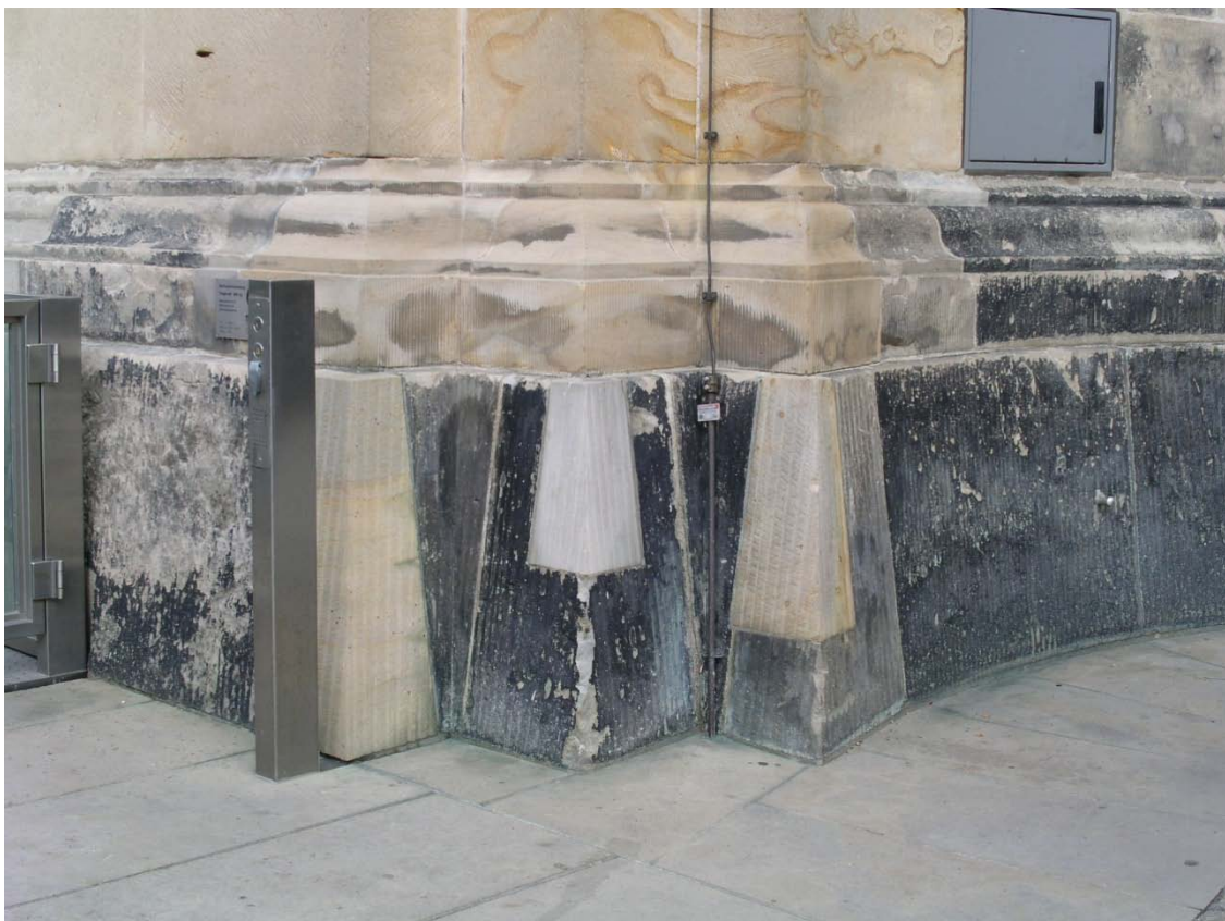
Figur 18: Delvis ødelagte sokkelsten utbedret som del av rekonstruksjonsarbeidet.
