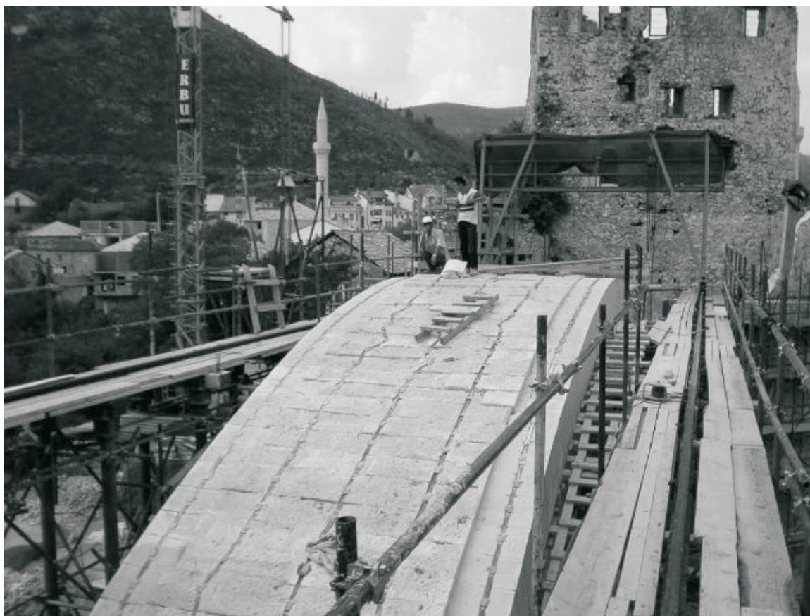
Figur 11: Den ferdige hvelvbuens overside, med kramper som forbinder blokkene.
