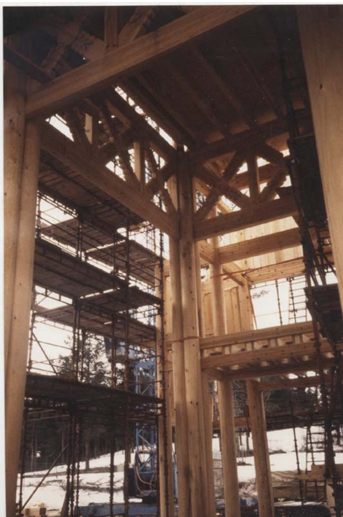
Figur 10: Stolpene i krysset under bygging
