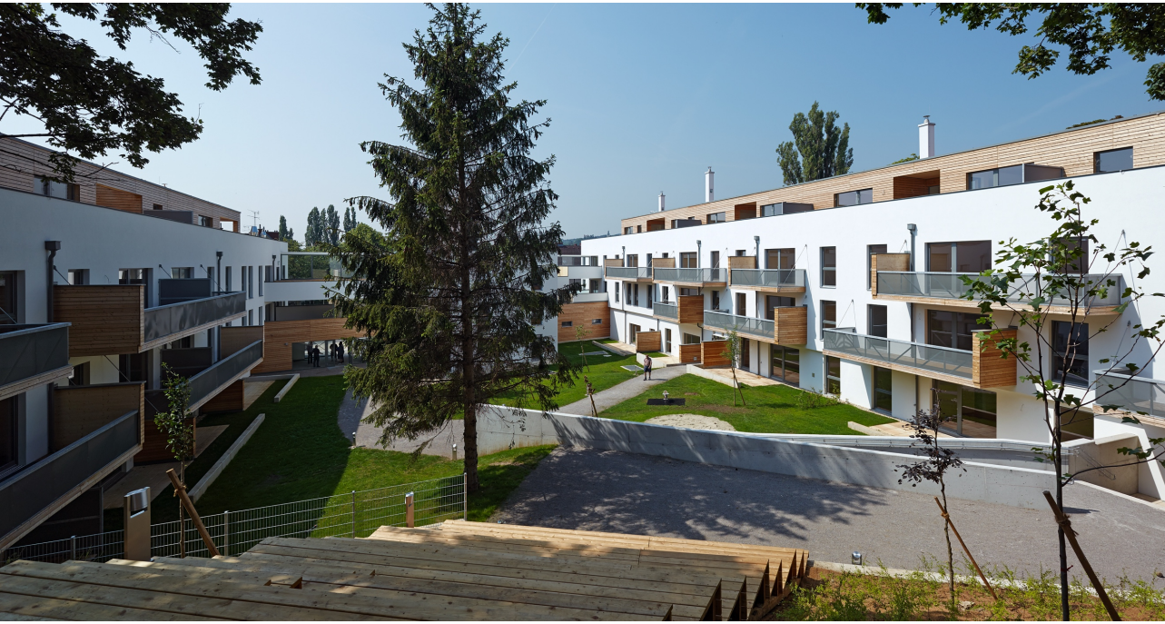
Figure 1.34 Breitenfurter Straße 2013, Architect: Praschl-Goodarzi Architekten, Photo: Bruno Klomfar
