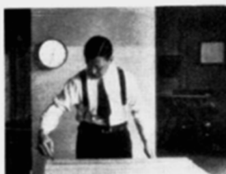
Fig. 156. Bruk av mal med stifter, der venstre hånd er overflødig under oppmerkingen. Gjennomsnittstid pr. stk. 0.0030 time.
