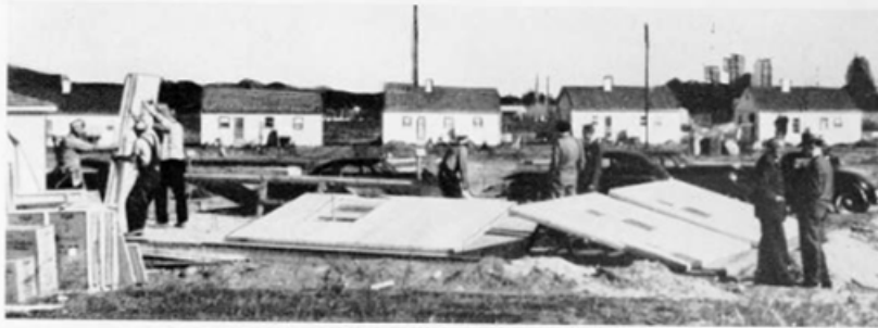
B. Kl. 0900 morgen. Adskillige deler er losset og lagt ut på plass på fundamentet.
