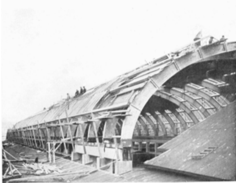
STOCKHOLMS CENTRALSTATION: Våthallen under uppmontering.
