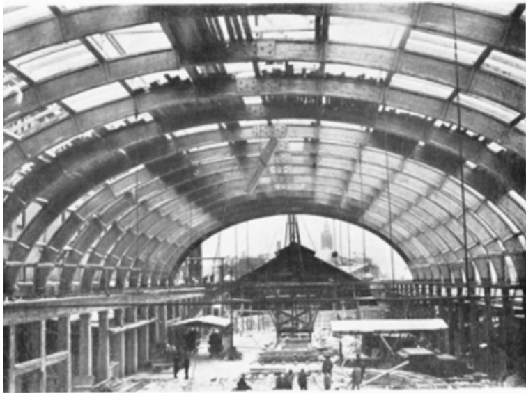
STOCKHOLMS CENTRALSTATION: Våthallen under uppmontering.
