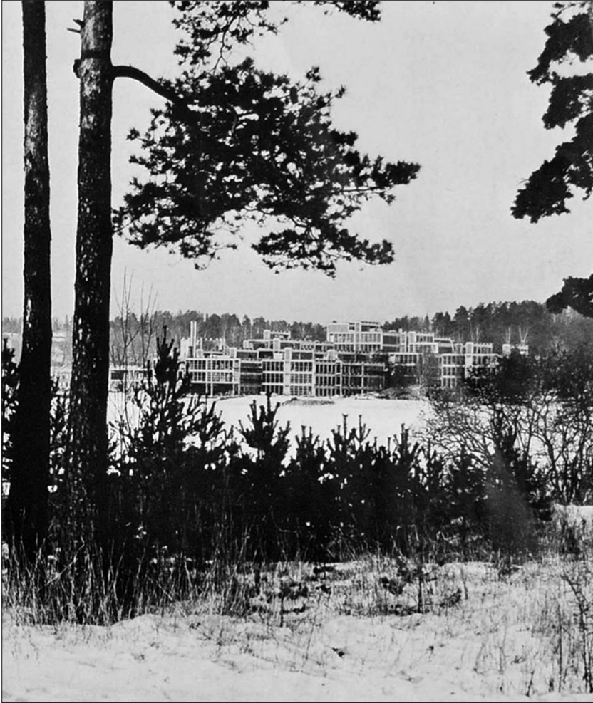
7: Veritas Complex, Lund & Slaatto, 1976 (Photo: Jon Haug).
