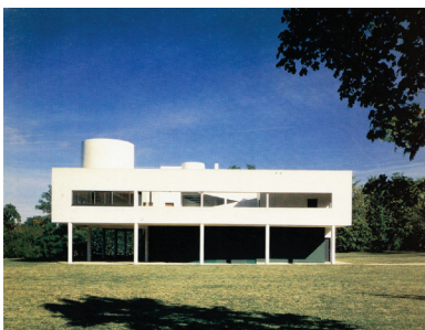
Foto: Fondation Le Corbusier
