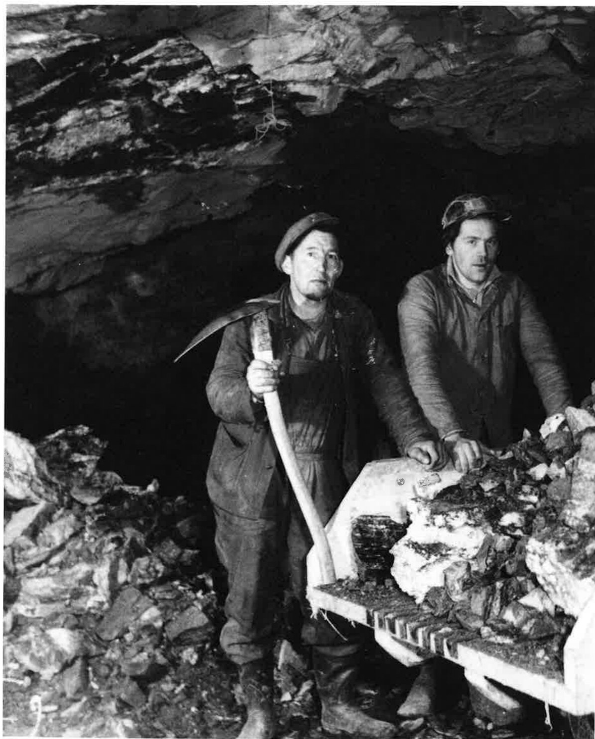
Håndlasting av trekkevogn, tidlig i 1950.
