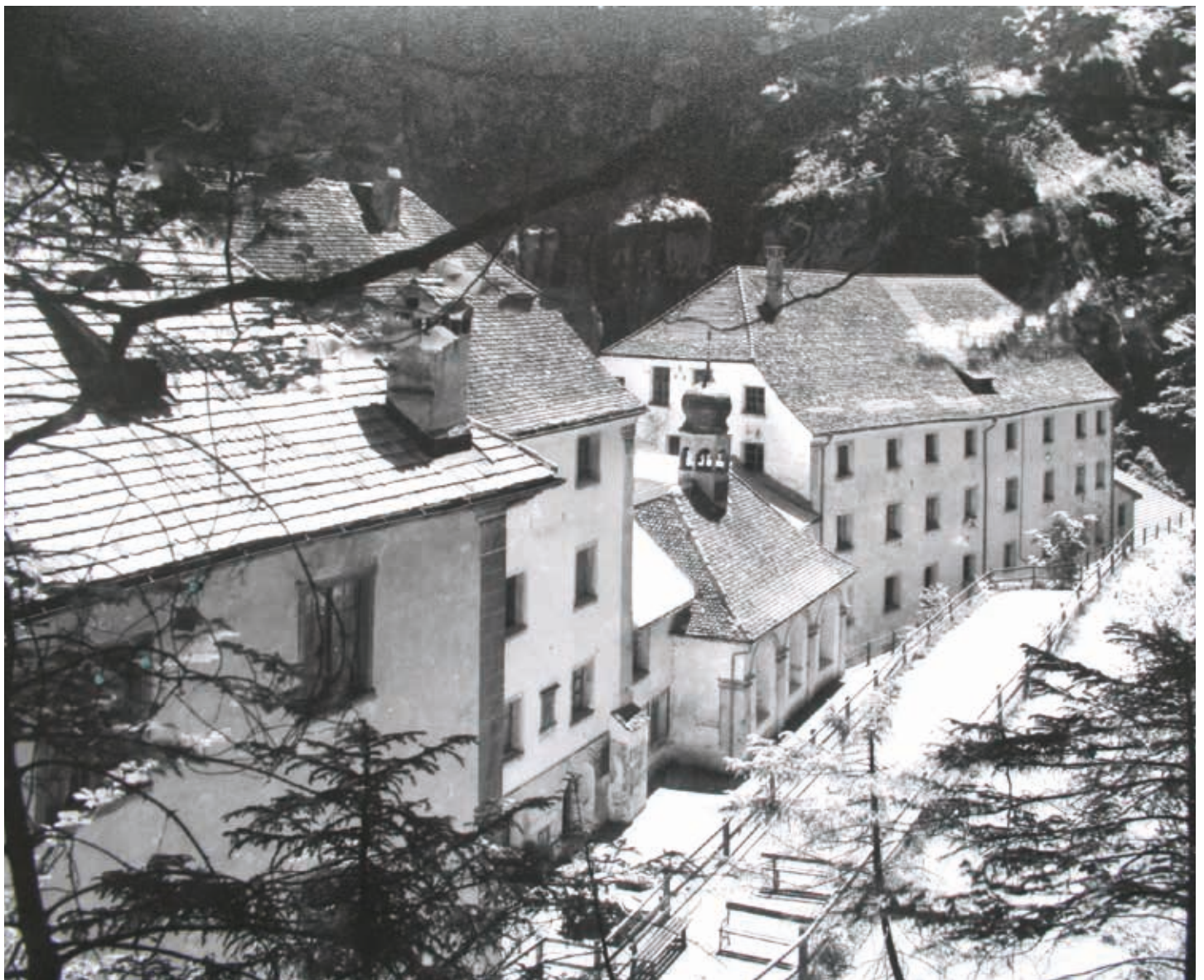
Die alten Badehäuser vor dem Abriss
