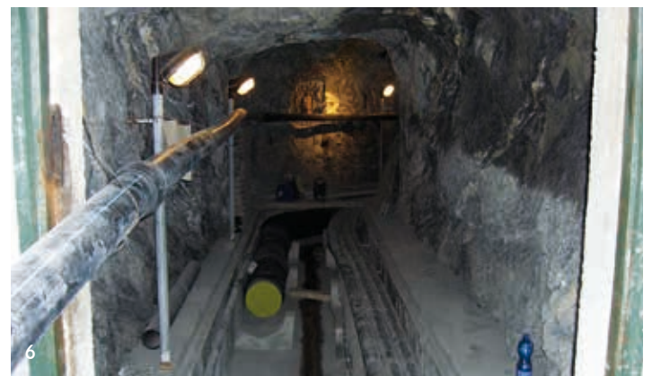
1 Leitung aus Holz (Holzteuchel) 2 Leitung aus Eternit mit Korkdämmung 3 Stahlrohr 4-6 heutige Leitungen aus Polyethylen mit PUR-Dämmung (PE)
