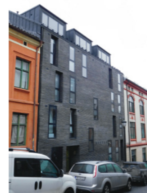
Nytt bygg i Korsgata på Grünerløkka i Oslo. Bygningen kontrasterer med den tilstøtende bebyggelsen, men høy kvalitet i fasadeforming, materialvalg og et tilpasset volum gjør prosjektet akseptabelt.
