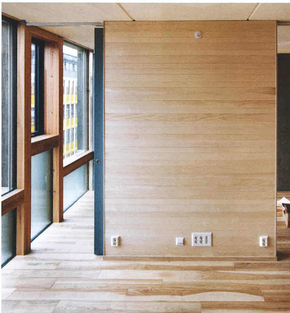
Gulv til tak: Små, ensidige leiligheter lider ofte under manglende lys og åpenhetsfølelse. Døråpninger som går fra gulv til tak og eksponerer den åpne vindusveggen er et grep som motvirker den innestengte følelsen. Gulvet er heltre ask, veggen inne i rommet er utført i osp. Floor-to-ceiling doors prevent a shut-in feel.
