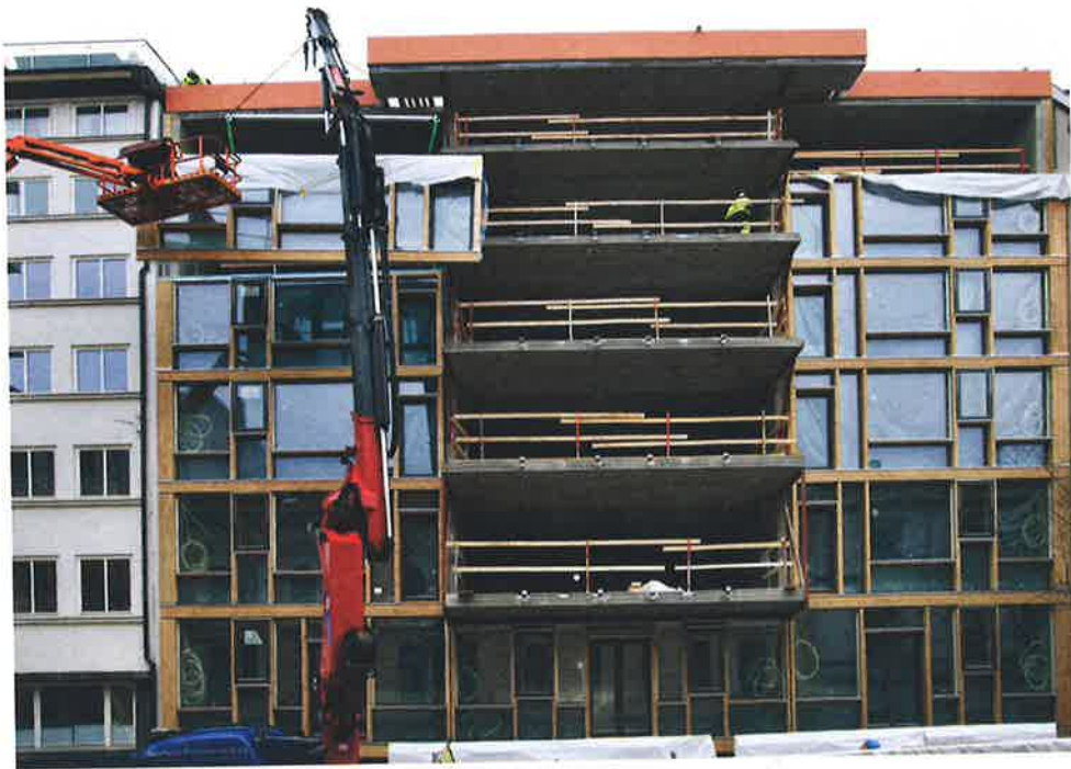
Elementbyggeri: Jensen og Skodvin hadde tenkt seg et hus med massivtre som bæring. Det ble for dristig for utbygger og entreprenør. Men fasaden er beholdt som et rent tre- (og glass-)produkt, her fra monteringen av fasadeelementene. Assembly of facade.
