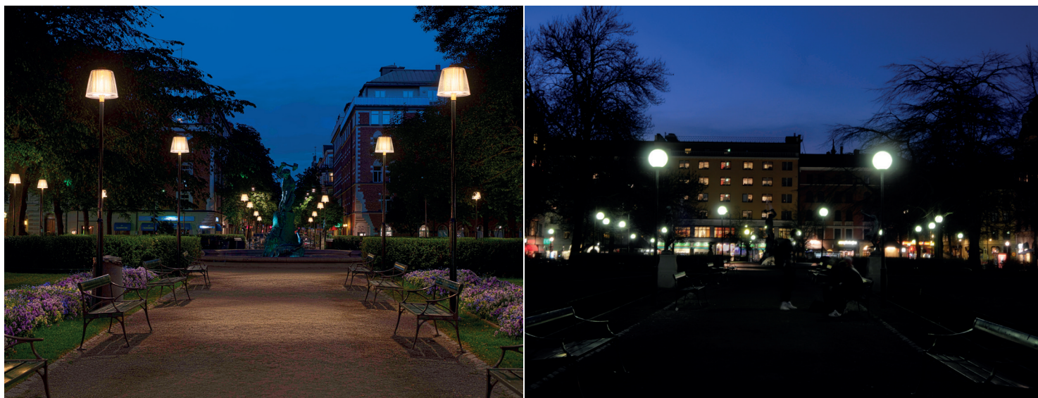
Illustrasjon 16 og 17: Belysning på Mariatorget i Stockholm. Til høyre er situasjon før utskiftning, til venstre er situasjon etter utskiftning, der belysningen er rettet ned mot bakken, der det behøves. Resultatet er mindre blanding og økt synlighet. Foto: Mikael Silkeborg, og ÅF Lighting
