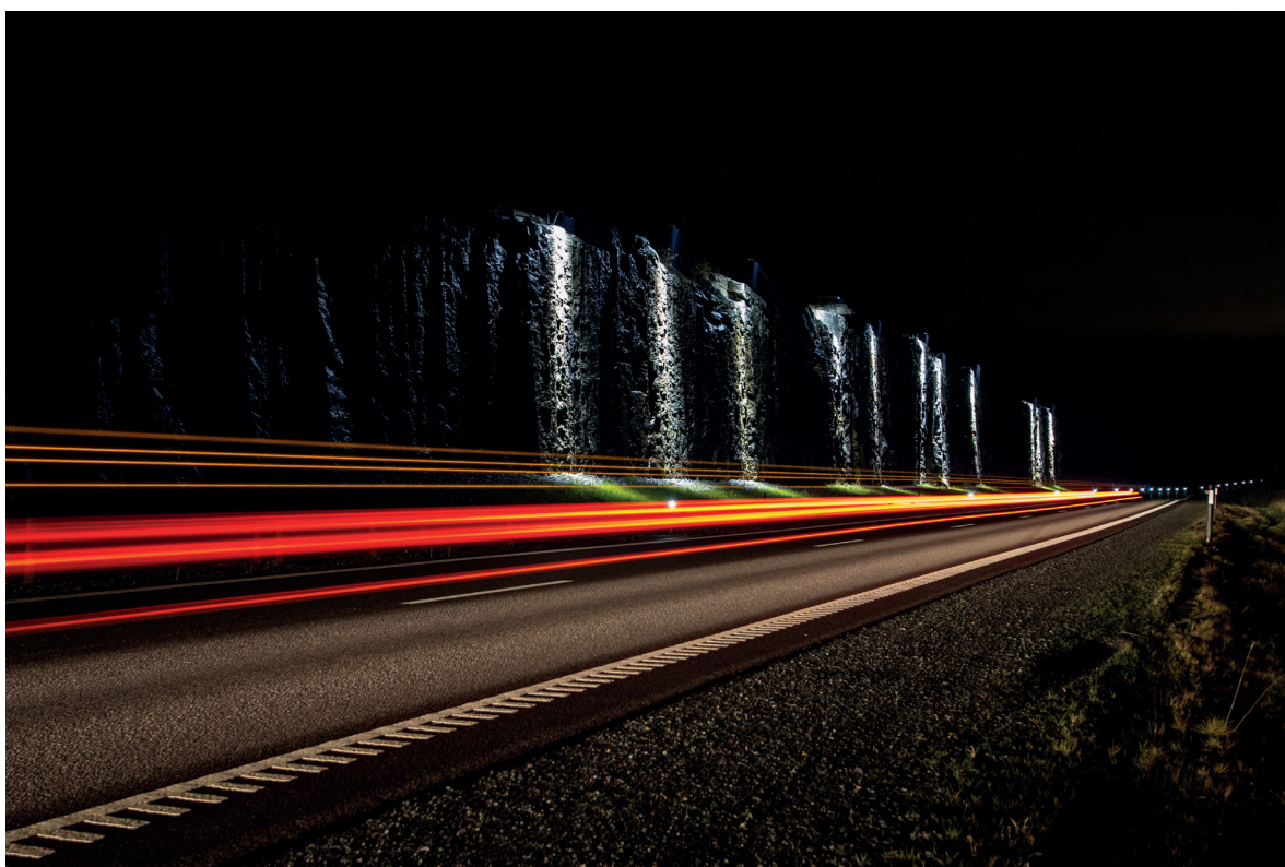
Illustrasjon 61: Effektbelysning langs E6 i forbindelse med prøveprosjekt med markeringslys i midtdeler som erstatning for tradisjonelt veilys. Foto: Tomasz Majewski
