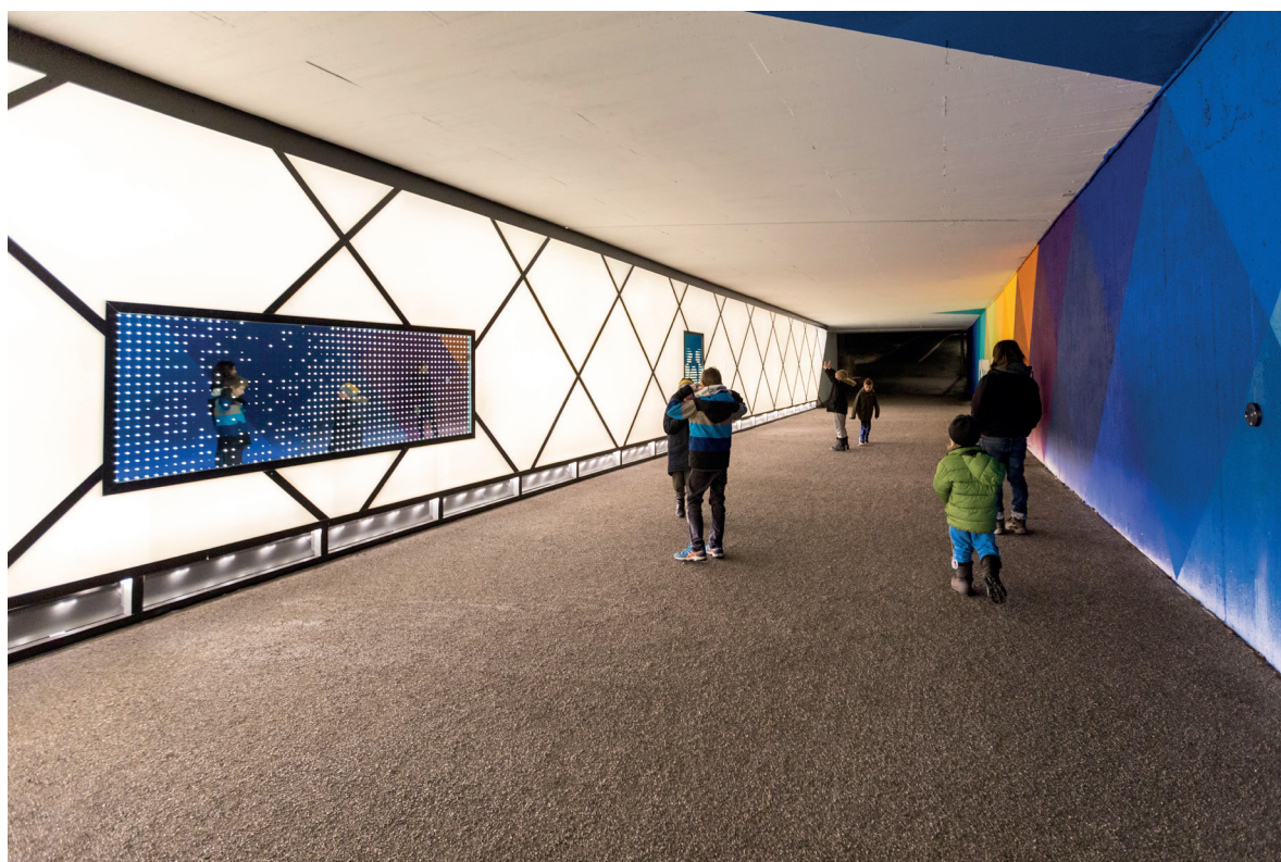
Illustrasjon 37: Belysningen i undergangen på Lindeberg består av en bakbelyst plexiplate som gir jevt lys til hele undergangen, samt to interaktive LED-plater der lyset tennes når man passerer og lager en lysende skygge. Foto: Tomasz Majewski
