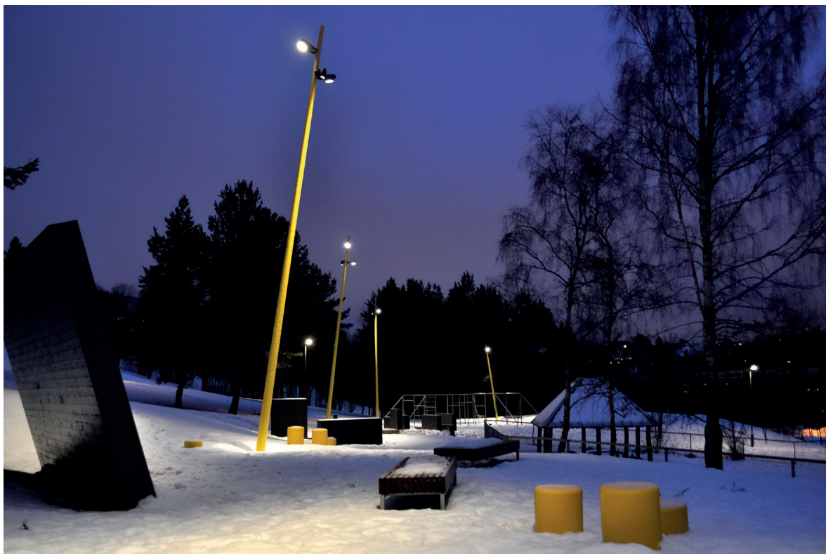
Illustrasjon 62: Fra Verdensparken på Furuset. Ved snøfall kan lysnivåene dimmes ned, et styringssystem med lyssensor kan la dette skje automatisk. Foto: Helga Iselin Wåseth
