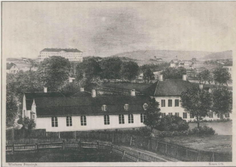
Fig. 1.9. “Grünings løkke ved Christiania.” Stentrykk. Hans Tøghe Winther, ca. 1845. Oslo Museum. Bebyggelsen som skimtes overfor våningshuset kan være Vendom løkke. Ruseløkkeveien går på oversiden av løkkeeiendommen i retning Ruseløkken, og svinger av ned til Klingenberg.
