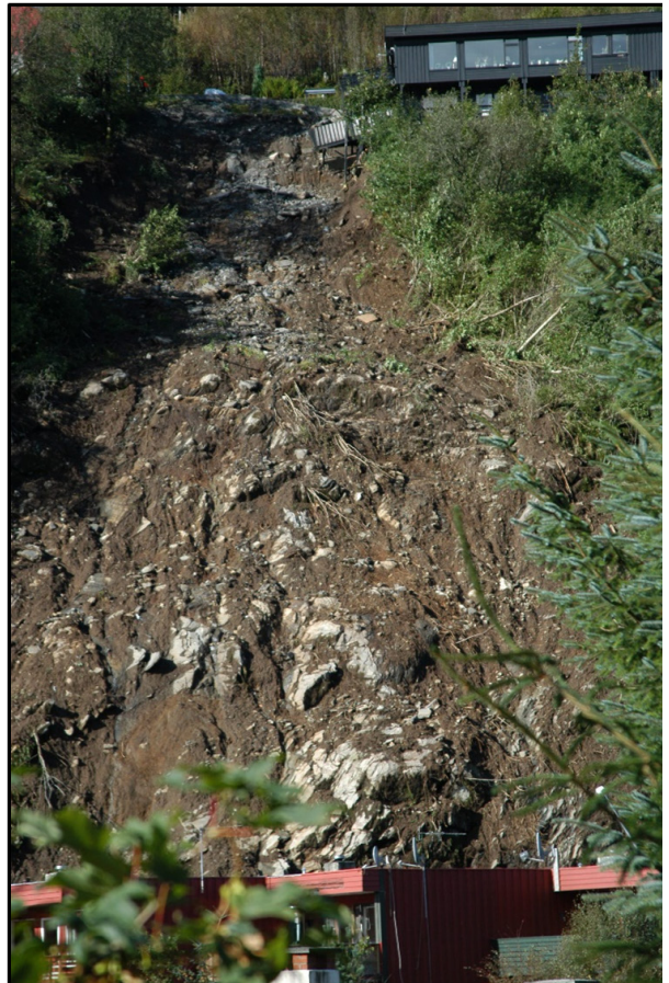
FIGUR 5 Jordras ved Hatlestad terrasse utløst av ekstremnedbør den 14. september 2005. Foto: Rolf Hordnes, Bergen kommune.
