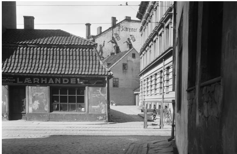
Bilde 32. Vognmannsgata 9. Persgangen mot Nygata. Datering omkring 1950
