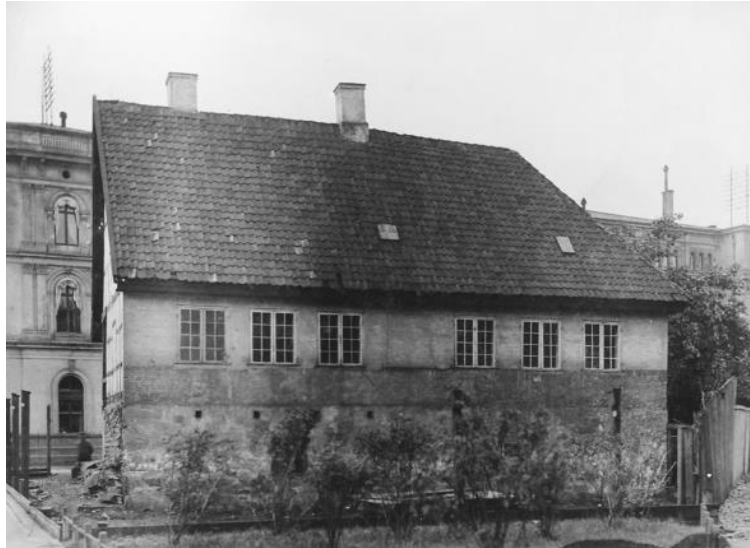
Bilde 5. Rett over veien for det staselige Paleet lå Meyergården. Fasaden til Meyergården var opprinnelig av laft, men ble senere dekket over. Fasaden var utmurt, det vil si fylt med murverk av teglstein. Senere kalkpusset og hvitmalt. Dette var en billig måte å dekke over laft for at fasaden skulle se ut som mur. Meyer (1745-1801) som ga navn til gården var sønn av en høker, og han drev selv også høkervirksomhet. Meyer solgte blant annet matvarer som saltet torsk og kjøtt, i tillegg drev han gjestehus. Trolig drev han også med innførsel av korn og utførsel av trelast. Hans sønn ble en av de rikeste i Christiania, og drev med trelast på 1820-tallet. Huset ble i 1909 demontert med tanke på gjenoppretting, men ble senere solgt som fyllmasse. Bildet er fra 1905. 60
