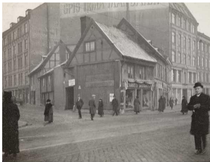
Bilde 13. Brugata 15 på hjørnet av Christian Krogs gate, omkring 1910-1920. Brugata 15 er et fint eksempel på tidlig sanering av gammel bebyggelse i 30-åra. På denne adressen holdt det som så mange andre steder opprinnelig til en garver og en høker. I 1900 var det kafevirksomhet og en skobutikk her som het "Lilletorgetts skotøymagasin". 151 Etter rivningen tidlig i 30-åra ble det oppført en toppmoderne bygård på adressen (se bilde 14).
