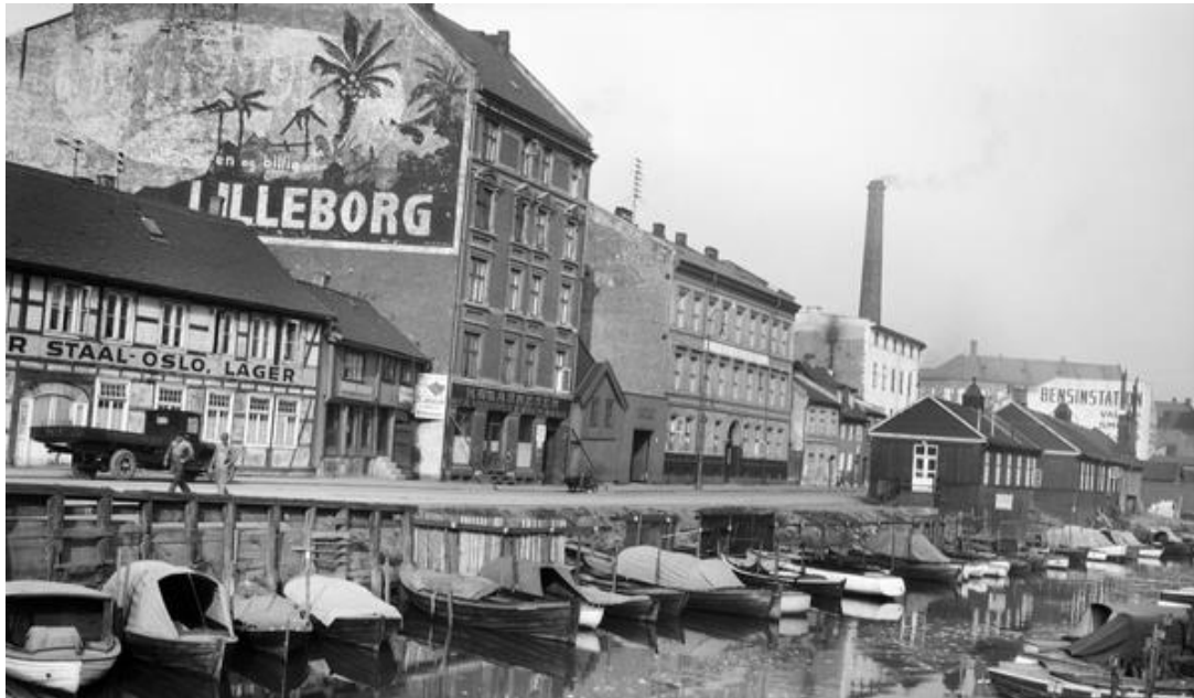
Bilde 11. Elvegata. Datering 1919. Bebyggelse langs Akerselvas nedre del. Nærheten til Akerselva ga gaten sitt navn, men langt tilbake het gata Bolverksgaten, etter bolverket som beskyttet mot flom fra elva. På bildet ser vi bygårder, bindingsverkshus og små trehus. Vi ser også småbåtlivet, som i dag så smått er på vei tilbake gjennom Akerselva trebåtforening.
