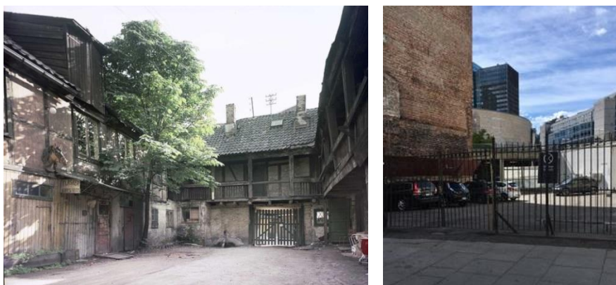
Bilde 26. Brugata 6 før brannen. Bildet til høyre er samme adresse mai 2020. I bakgrunn ser vi deler av Oslo Spektrum og Postgirobygget.
