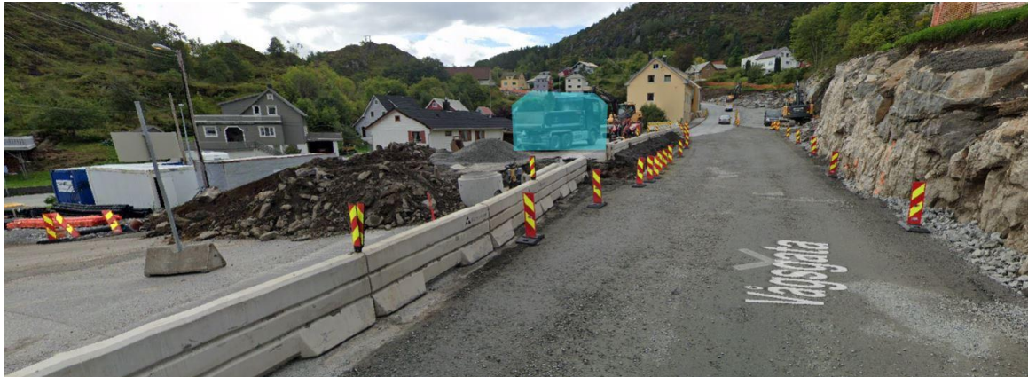
Figur 5.46: Biletet er teke i Vågsgata i sørleg retning. Det turkise feltet er eit forsøk på å peile inn om lag der tunnelinnslaget til Pedersen ville munne ut i Vågsgata.
