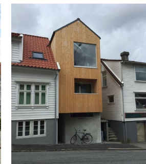
Figur 42 Langgata Stavanger, Foto: Austigard Arkitektur
