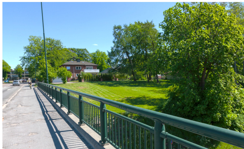
Figur 62 Parken mellom Thorneløkka og Rådhusbroen.
