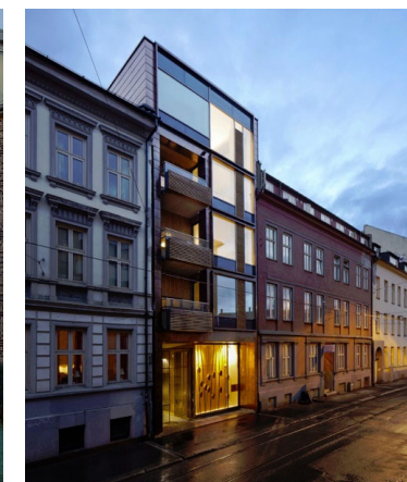
Figur 44 Parkveien Oslo, Foto: Kima arkitektur
