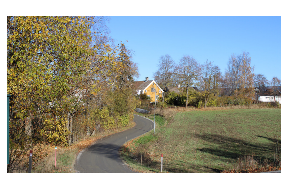
Bergenske kongevei fra Pilegrimssenteret mot nord
