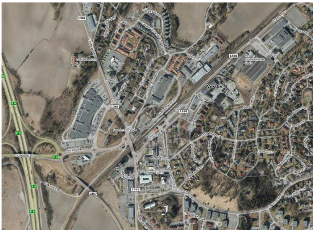
Figur 1: Flyfoto fra 1881.no som viser tettstedet Vestby. Riksveien 1 fra Svinesund til Oslo som i dag er E6, gikk tidligere på Vestbyveien som krysser jernbanen rett syd for stasjonen.
