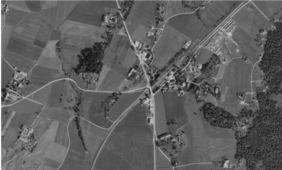
Figur 13: Flyfoto over Vestby fra 1950 (1881.com) Stedet er bygget ut med handel, sagbruk, skole, kulturhus (Festiviteten) og mølle. Bebyggelsen er konsentrert rundt stasjonen og langs Mosseveien.
