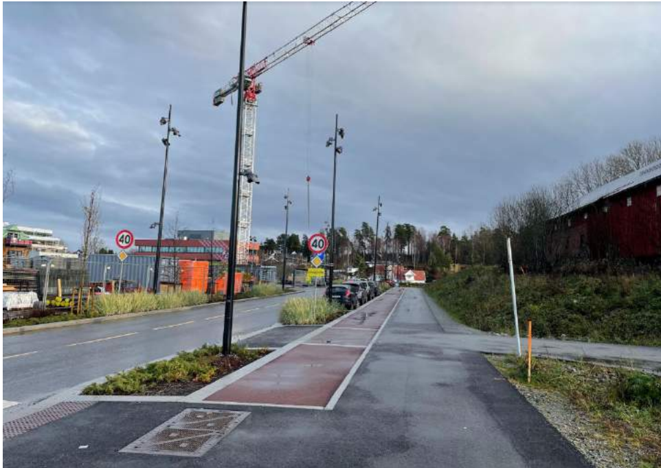
Figur 33: Bilde fra Sentrumsveien som har blitt bygget om fra vei til gate med vegetasjonsfelt, sykkelfelt, gateparkering og fortau. Til høyere ses låven på Nordby gård, som er ikke er regulert til bevaring. Heisekranen er satt opp i forbindelse med bygging av det nye kulturkvartalet. Det skal være ferdig i 2023. Fra Sentrumsveien har man visuell forbindelse til åser med vegetasjon og fornminner.
