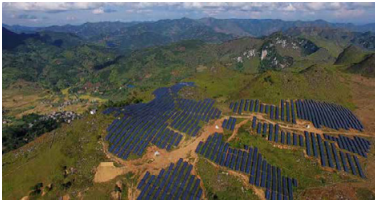
图3 板万村卜公山南向山坡上覆盖着大量光伏太阳能矩阵
