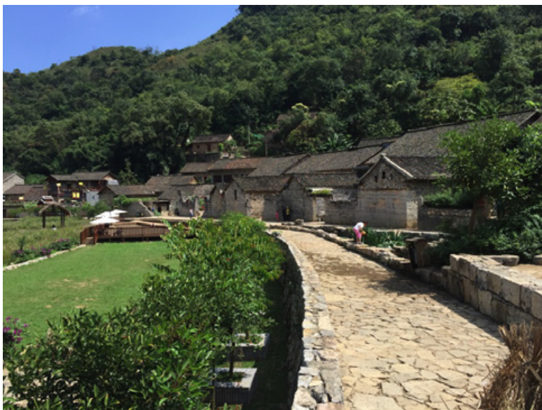
图4：基础设施改造不仅是物理设施的升级，也促进乡村空间的适应更新。图为雨补鲁村的改造中将水渠、步道和景观有机结合起来。（来源：曹卿拍摄）
