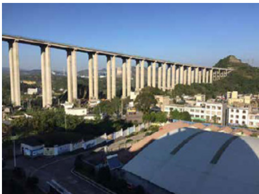
图4 南昆铁路兴义段的高架桥
