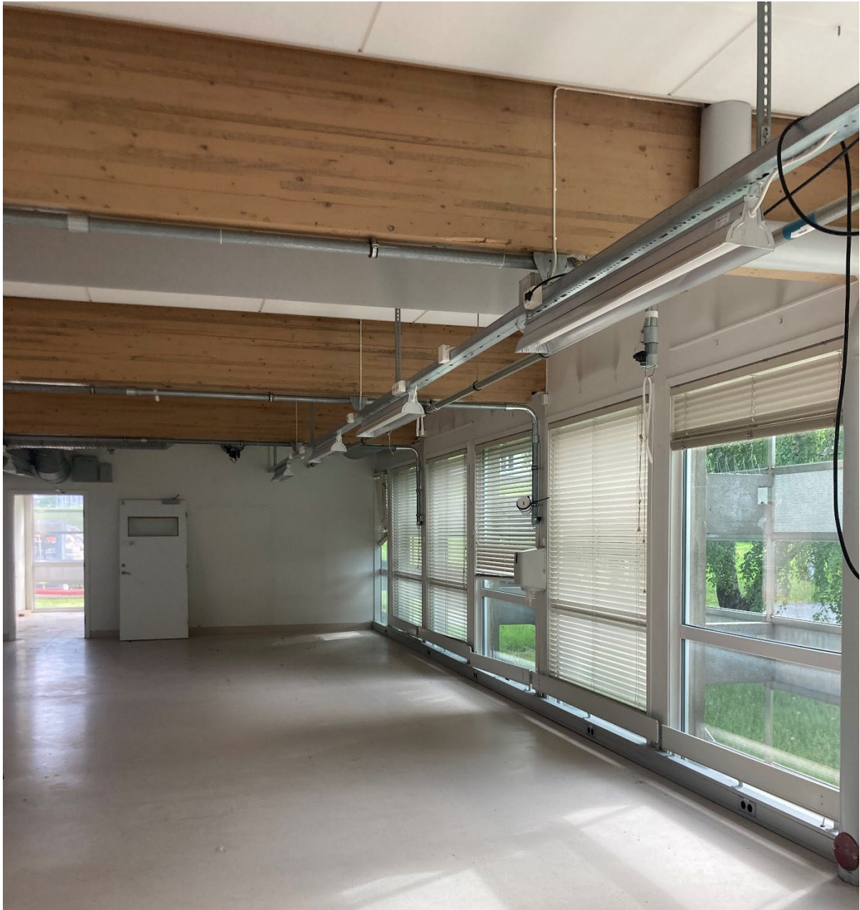
Figur 20: Interiør etter utflytting - Foto: Lene Utbjoe 2022
