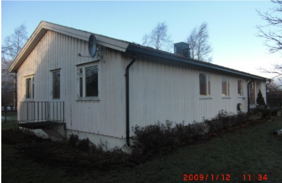
Gjerdrum prestebolig. Fasader med soveromsfløy og inngangsparti. Foto: Ovf
