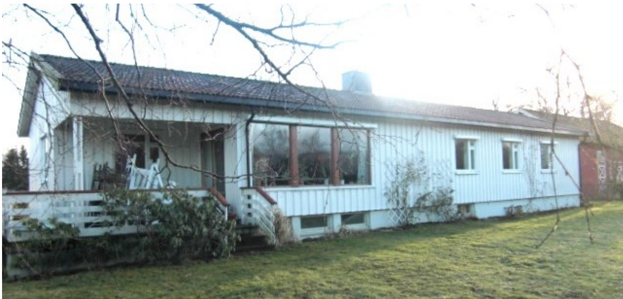
Gjerdrum prestebolig. Fasade mot hagen med kontordelen til venstre i bildet. Foto:Ovf
