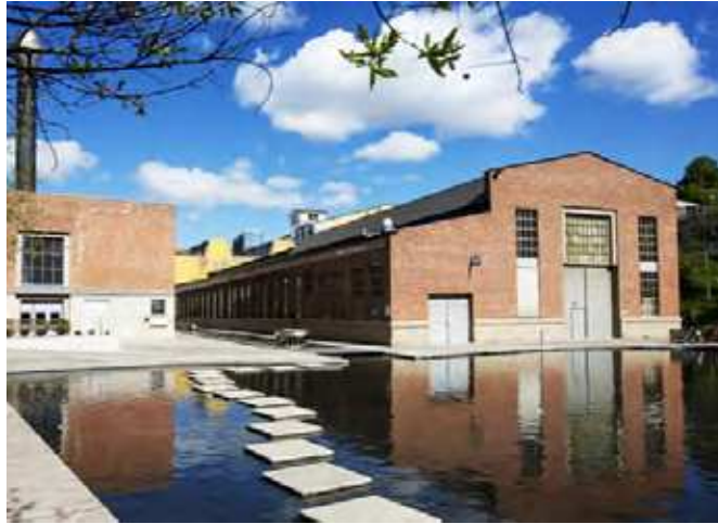
Verkedshallen før riving og transformasjon. © OBOS/Nadia Frantsen.
