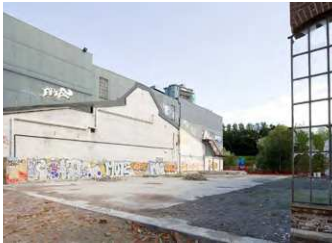
Situasjonen etter riving av en del av broverkstedet. © Vulkan eiendom 2009.
