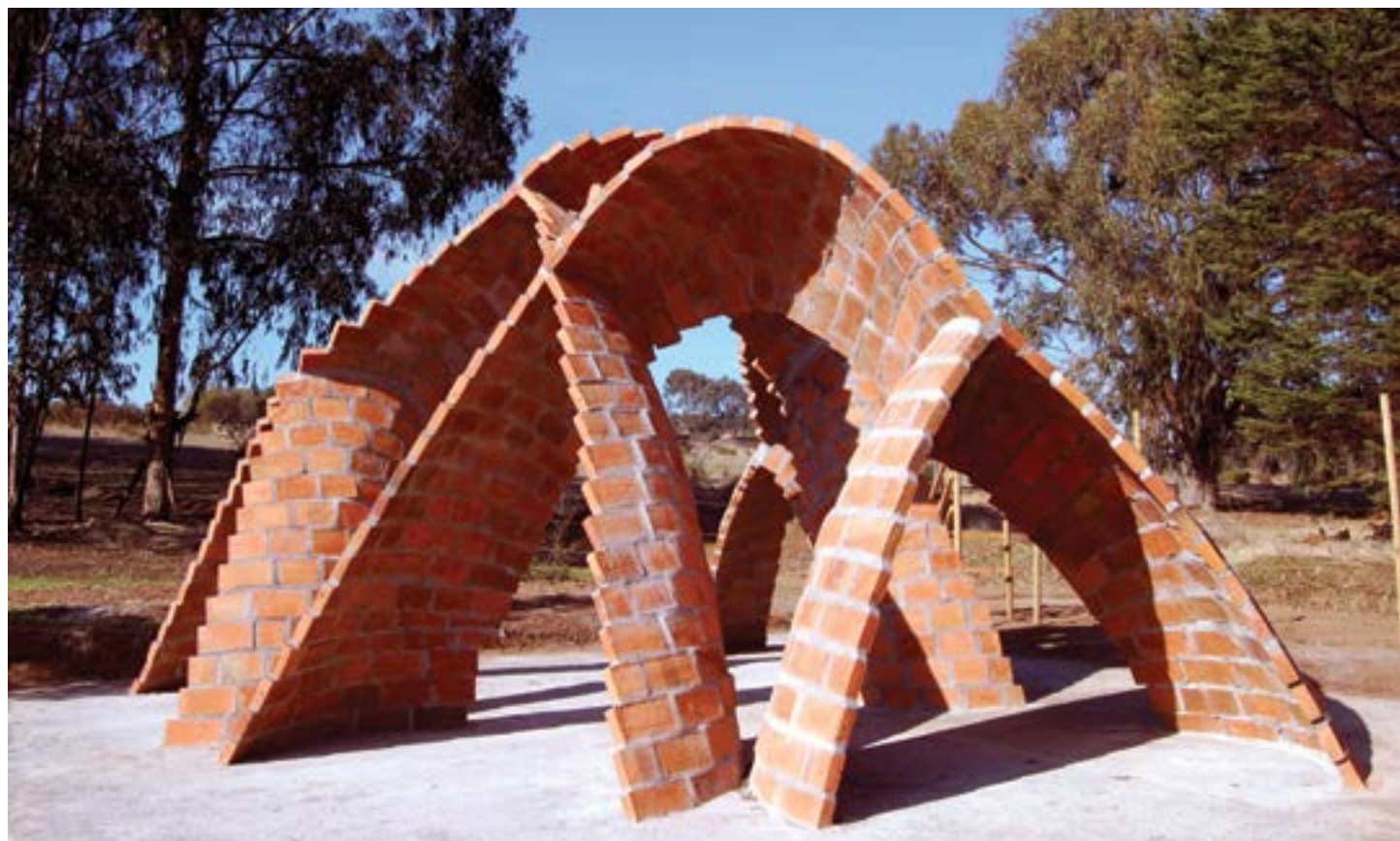
Nested Catenaries. Den ferdige konstruksjonen. Under: Statistiske modeller. Nested Catenaries. The completed structure. Below: Structural analysis.
