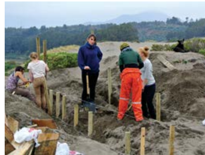
Hospederia de las Alas. Fra byggeprosessen. Hospederia de las Alas. From the construction process.
