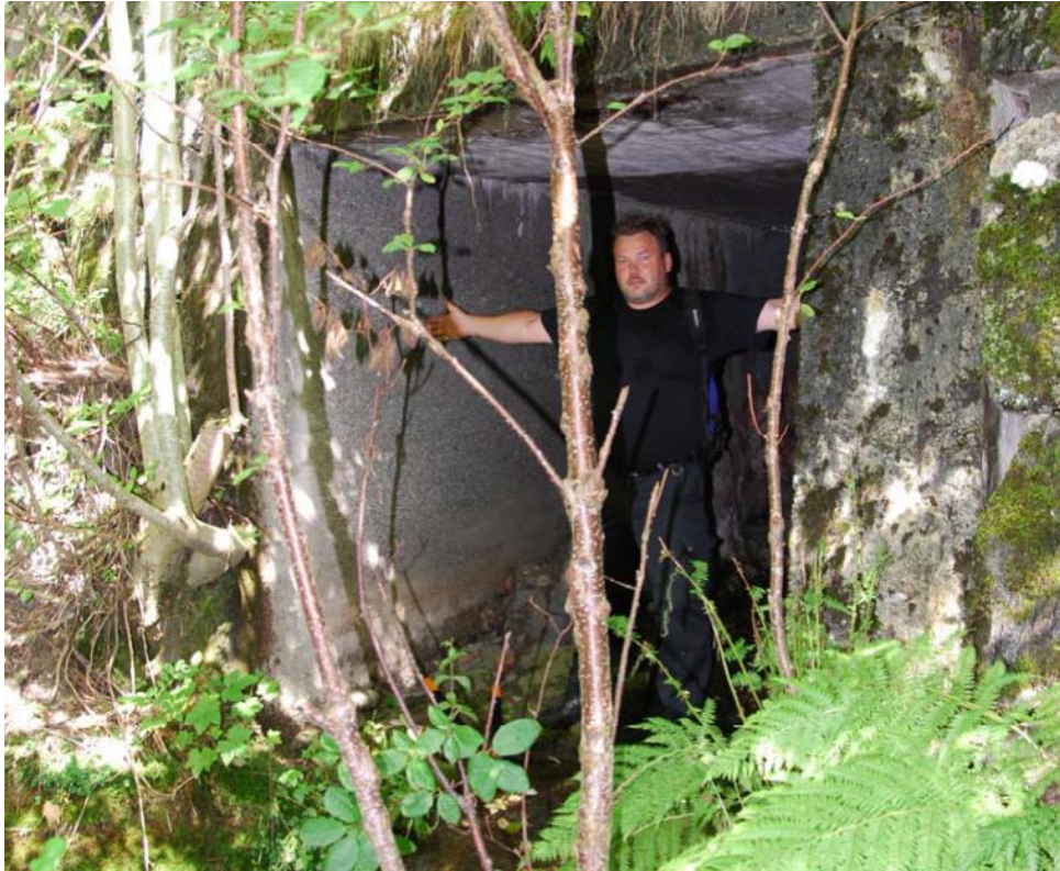
Foto 11 Opning i fundament under brua / riksvegen.
