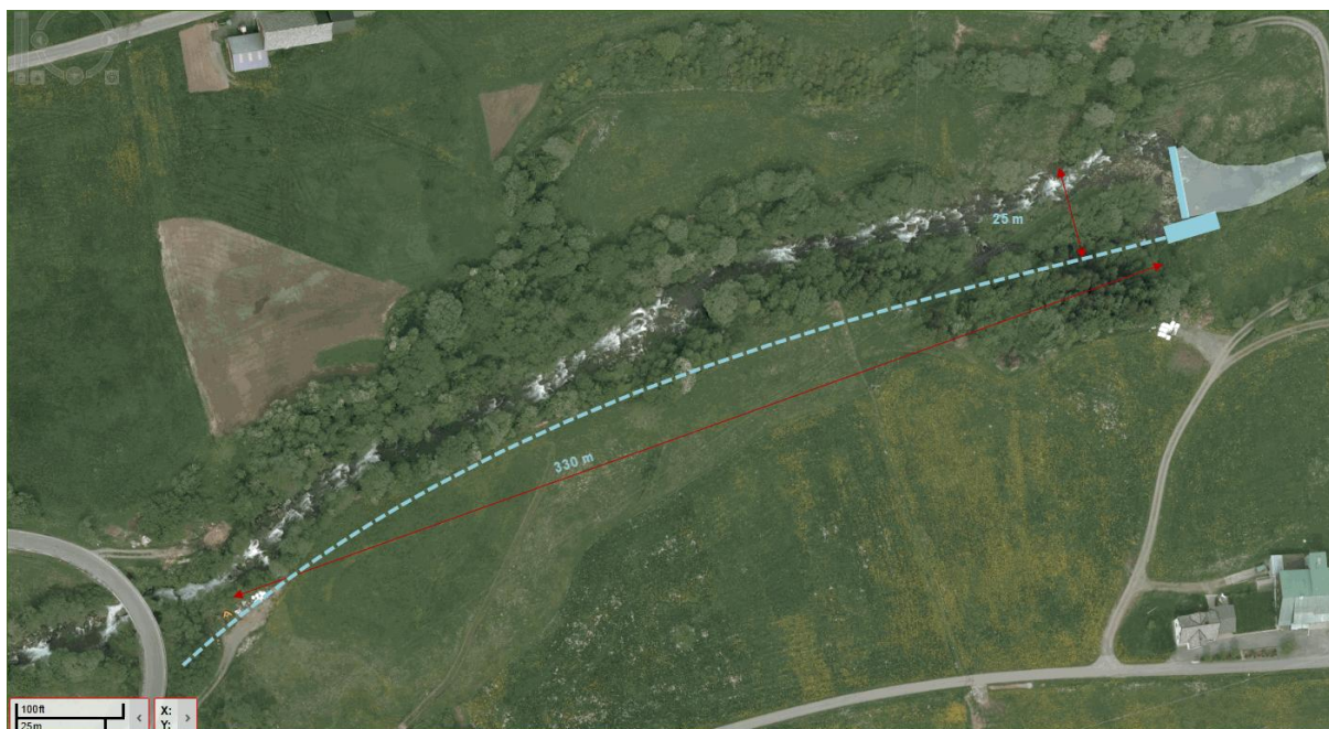
Figur 3.17.1 Foto viser elv mellom inntak og riksveg.
