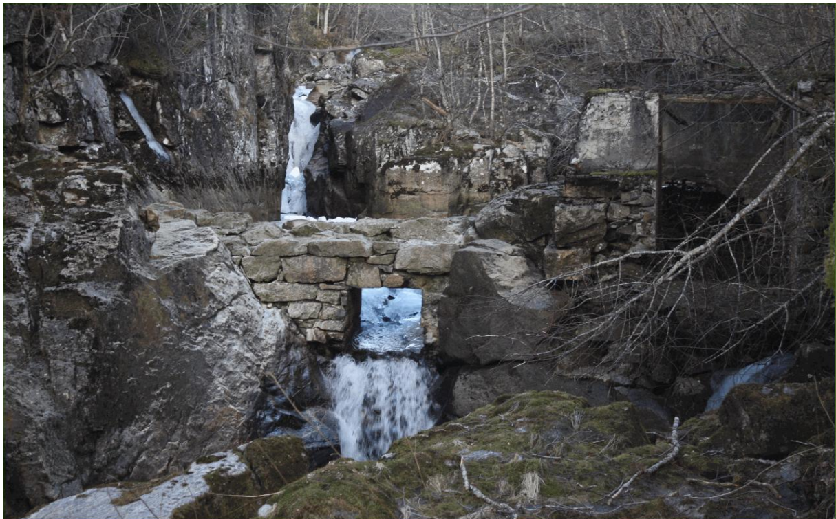
Foto 10 Restar av det gamle kraftverksinntaket.
