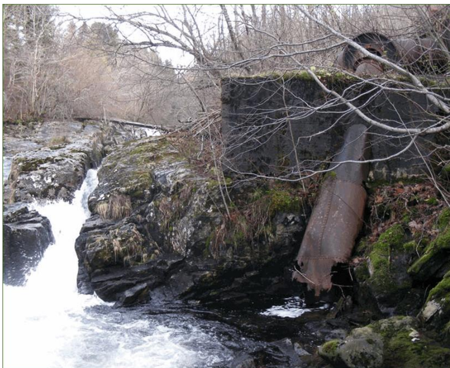
Figur 2.2.6.3 Foto av fundamentet til den gamle kraftstasjonen.
