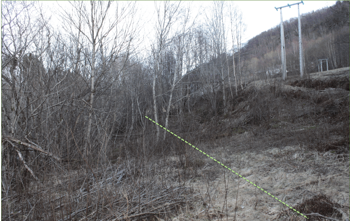
Foto 7 Rørtrase ned mot kraftstasjon.
