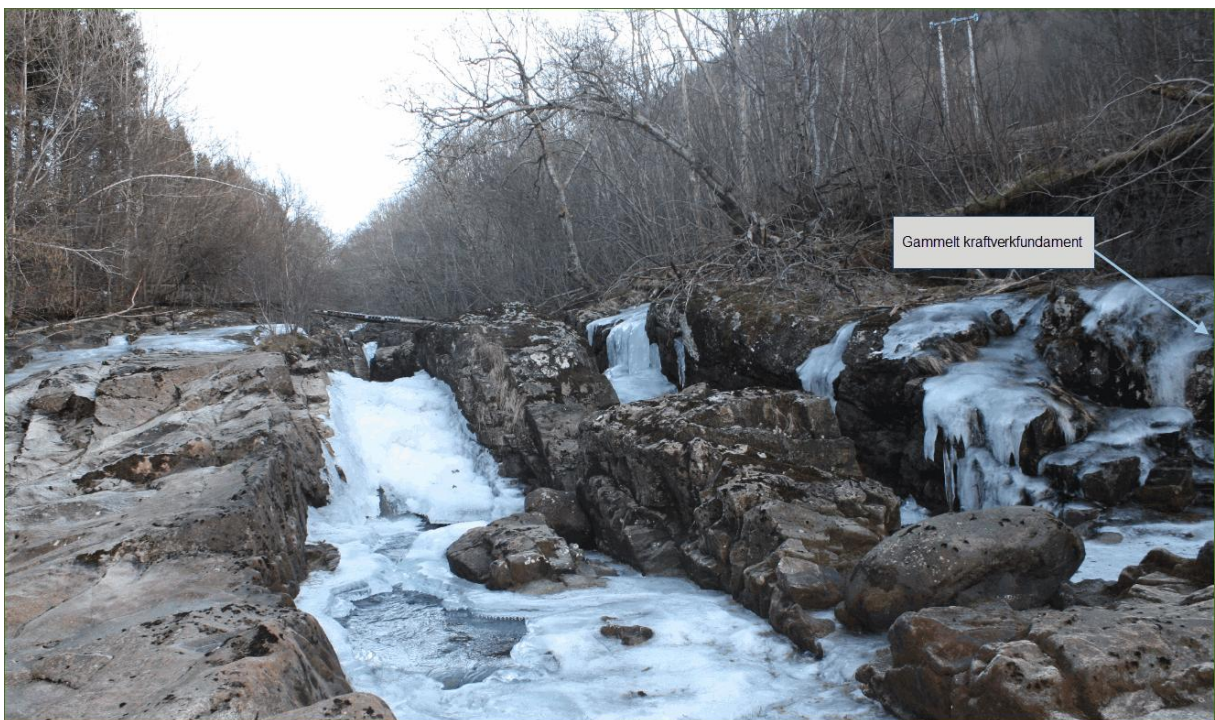
Foto 4 "Byksehølen", vandringshinder for laks ved det gamle stasjonsfundamentet.
