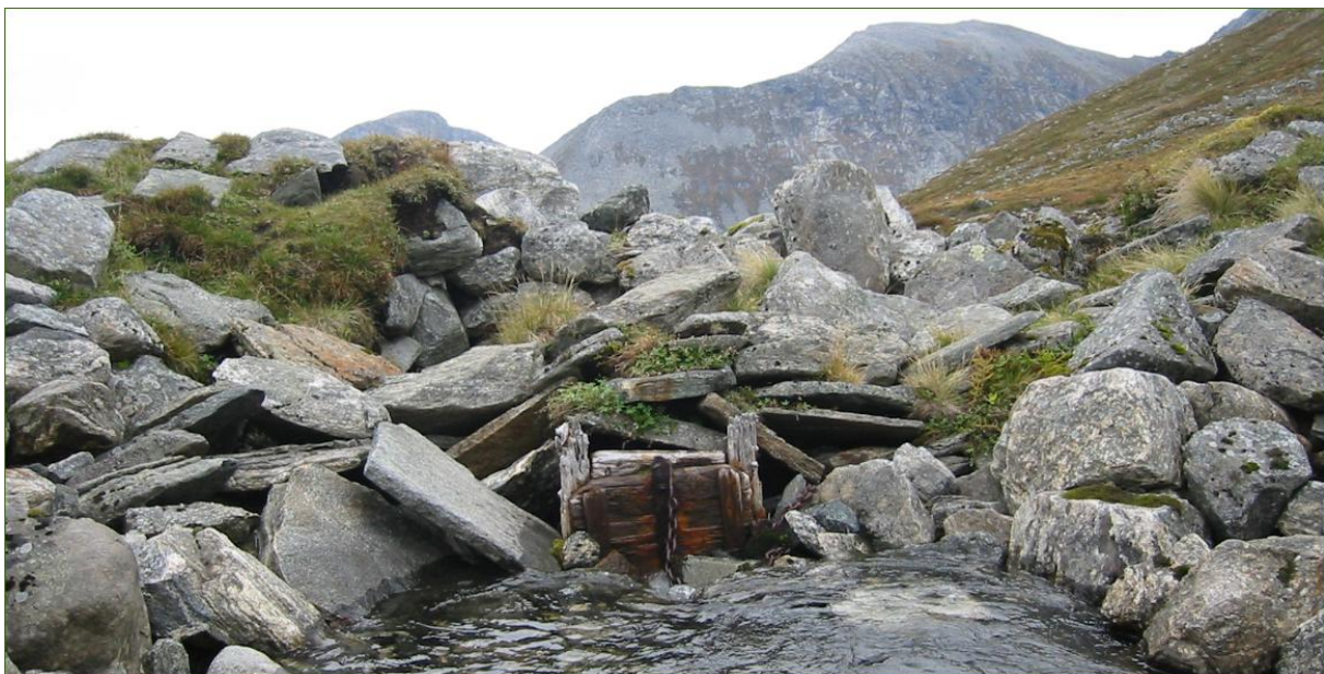
Figur 3.10.3 Fyllingsdam og restar av luke for vassregulering til gamle Vaksvik kraftverk ved Litlebotnvatnet.
