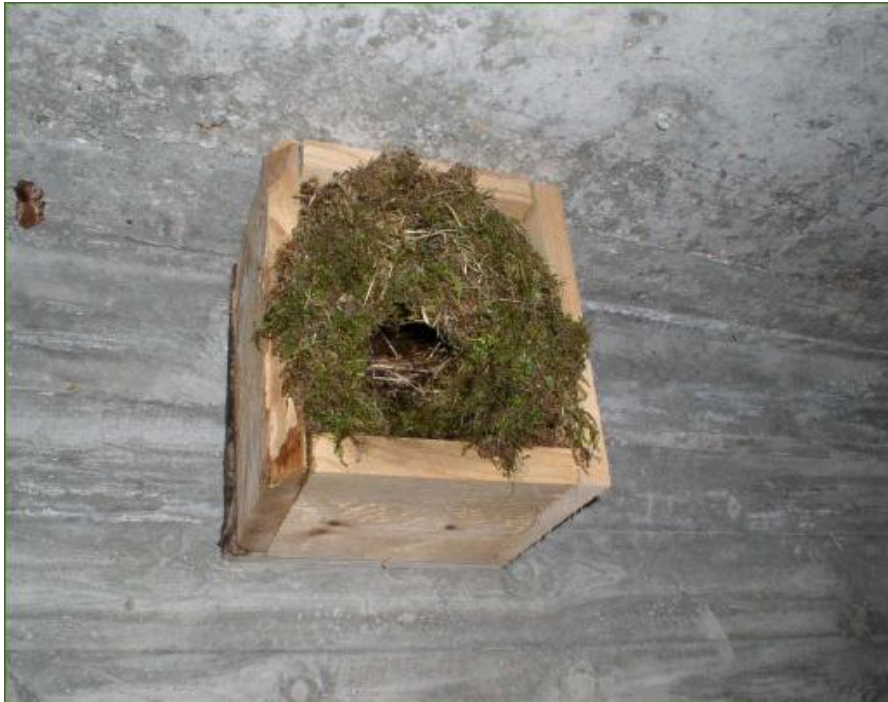
Figur 4.2.1 Fossefallreir i kunstig reirkasse som er montert under ei bru.
