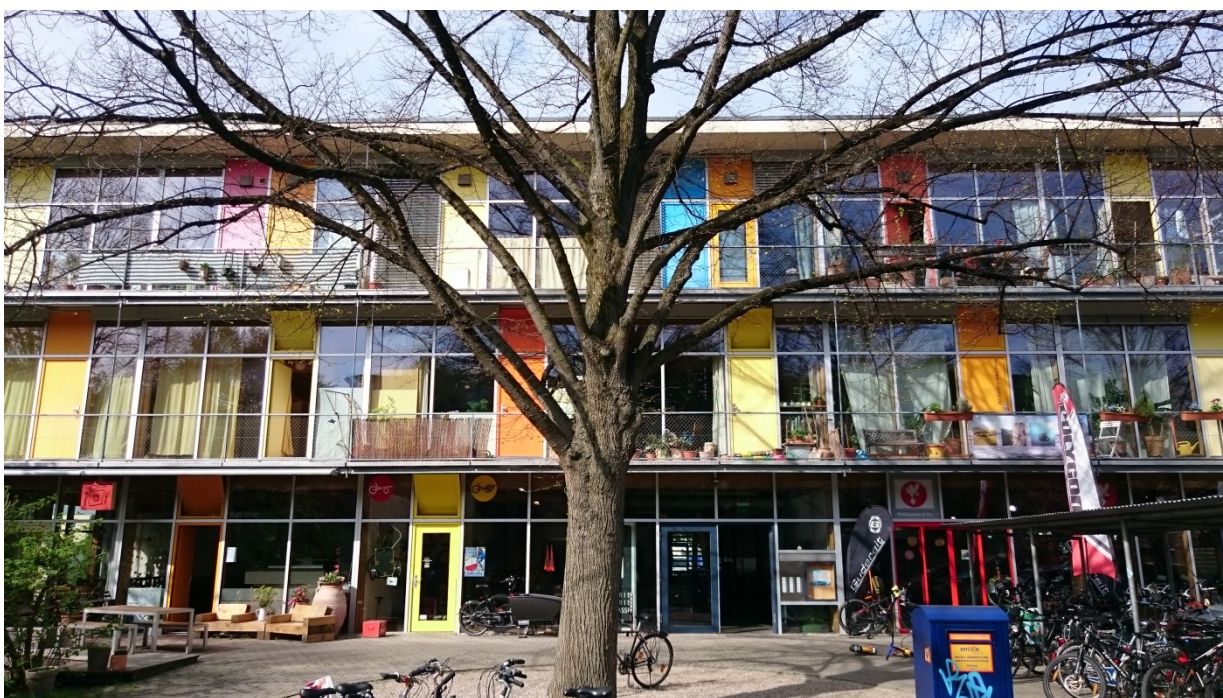
18. "VillaBan" er utformet som et stort kvadrat med 3,3 m høye etasjer. Bygget inneholder en rekke butikker, verksteder, studio og kontorer – i tillegg til boliger. Generelt er over 400 arbeidsplasser skapt i Vauban siden oppstarten (Stadt Freiburg, 2016)
