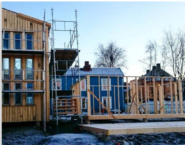
Rekkehusene under oppføring januar 2016
