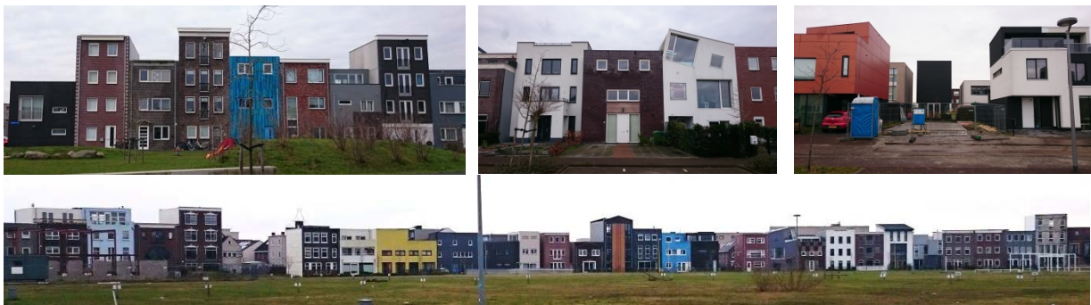
82. Tett småhusbebyggelse av selvbyggerboliger, Homeruskwartier, Almere. Foto fra befarig i februar 2016
