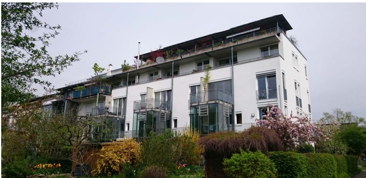
Figur 15. Eksempel på byggefelleskap i Rieselfeld. Foto fra befarung april 2016
