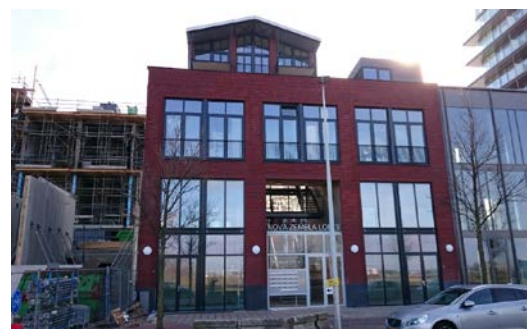
75. Ridderspoorweg nr. 21 under bygging, februar 2016 (eget bilde).
