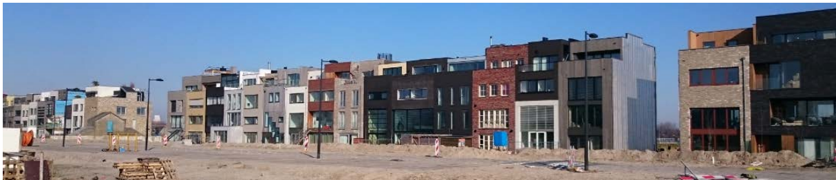
69. Første byggetrinn er nesten komplett (egne bilder, februar 2016).
