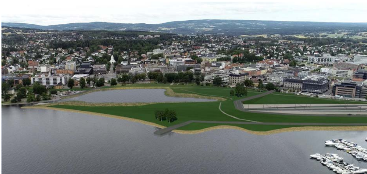
Figur 14: Forslag til nytt og ytterlegare senka vest-alternativ. Den nye løysinga gjer det mogleg å etablere ein vasspegel på innsida av kulverten. Her vist med varianten med langt lokk og tilkomst til Tjuvholmen over kulvertlokket. Illustrasjon: Bane NOR SF (2019a, 46).
