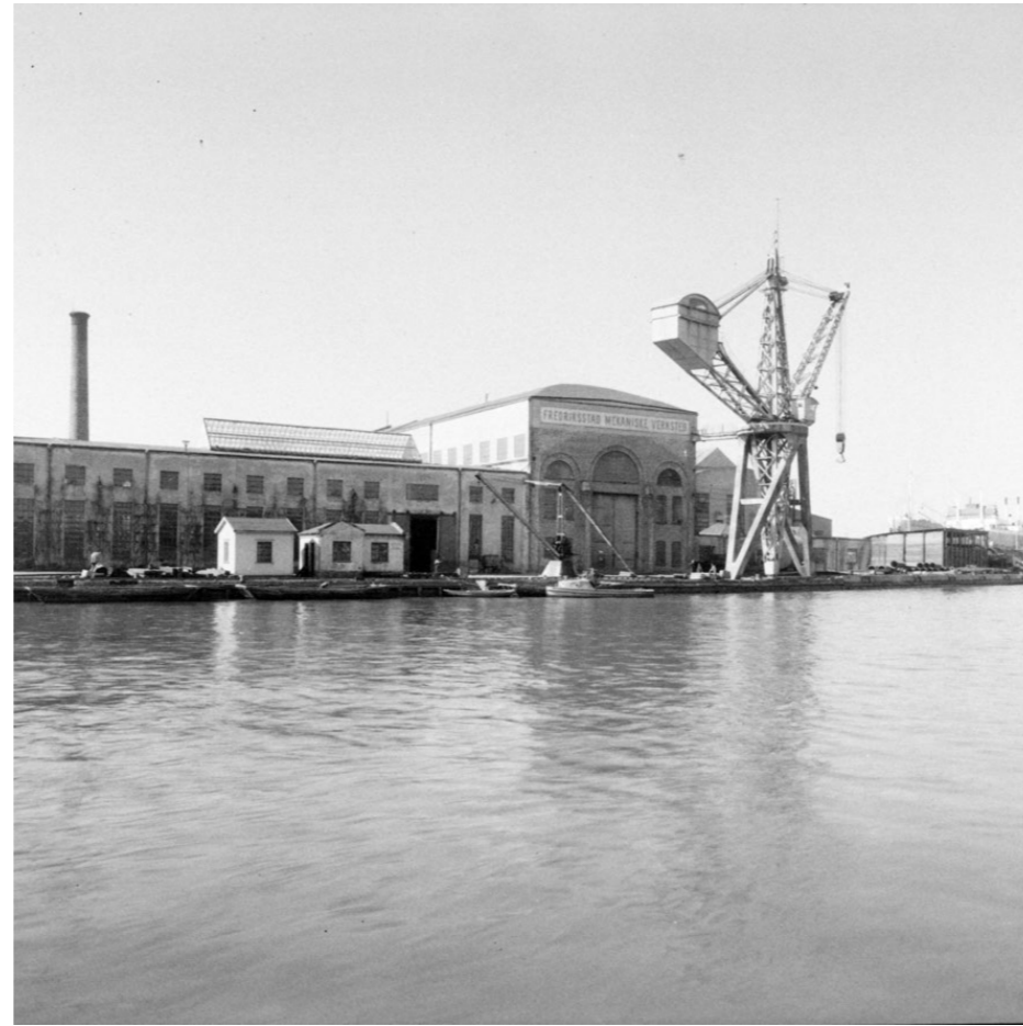
Fredrikstad Mekaniske Verksted (1898)
