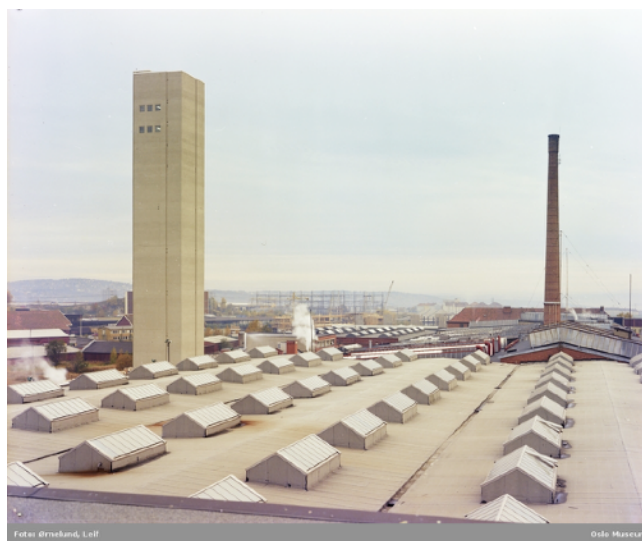
Standard telefon- og kabelfabrikk fotografert i 1967. Kabeltårnet er oppført i betong.
