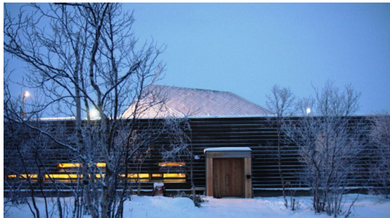
East Sámi museum in Neiden. Architects: Pir II arkitektkontor. Photo: Honna Havas 56
