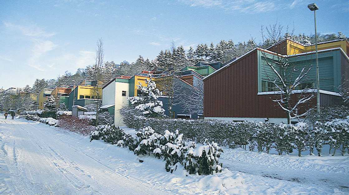
Figur 2. Selegrend I, kjent som Hesthaugen Selegrend. De siste 25 årene har boligområdet lyst opp i terrenget med sin karakteristiske fargepalett, et resultat av en fargesettingsprosess utført i 1997 av Nils Roar Øvsthus, en av prosjektets opprinnelige arkitekter. Foto: Nils Roar Øvsthus/Arkitektgruppen CUBUS.
