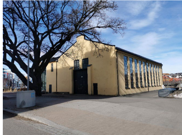
Figur 39 Støperiet, bevaring av industrihistorie
