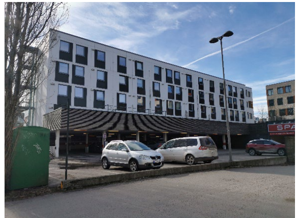
Figur 31 Parkering fyller gårdsrommet i Delfelt F
