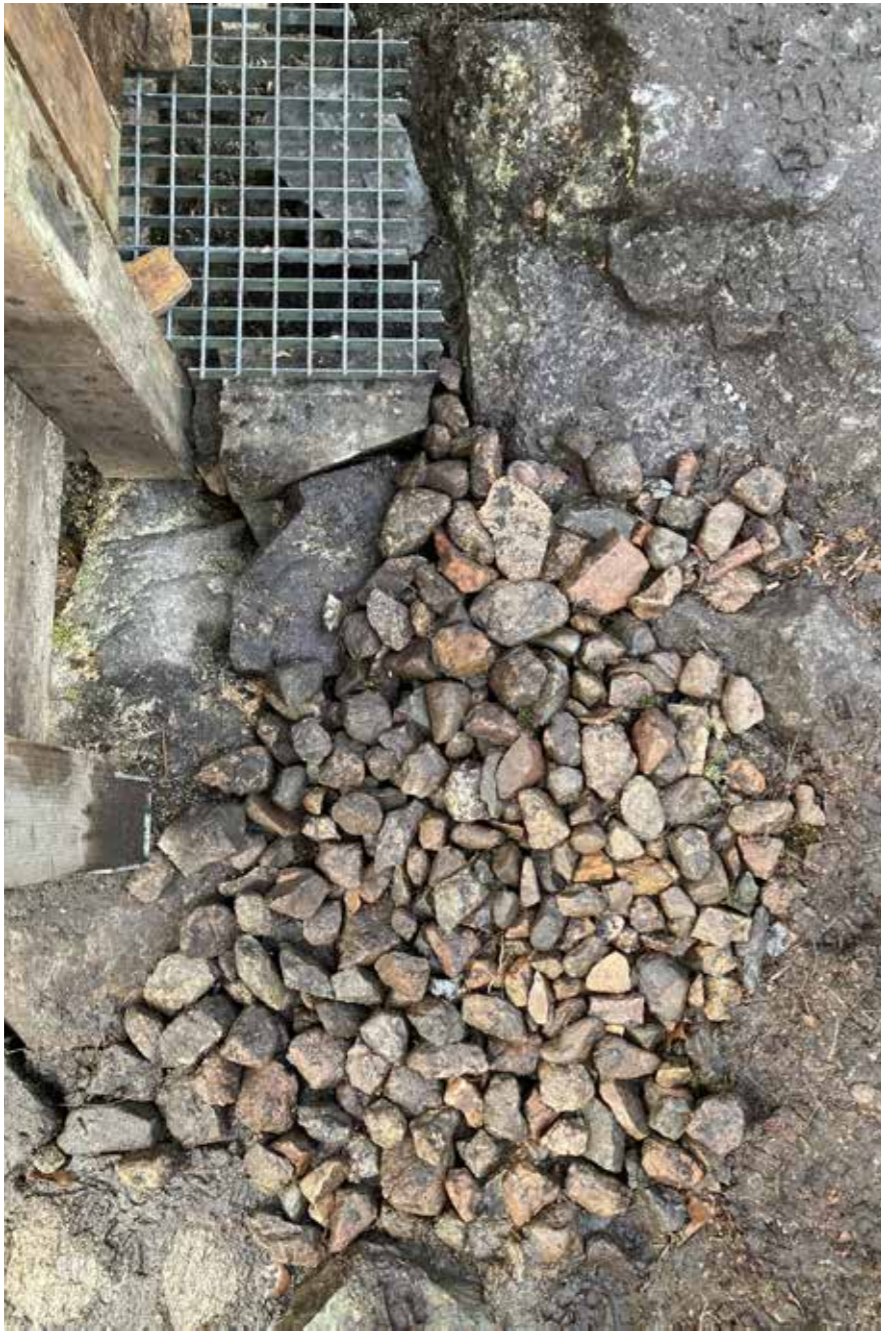
Stein fra rydding av tomten har vi brukt for å jevne ut inngangspartiet hvor elefantristen strekker seg ut av bygget og treffer fjellet.
