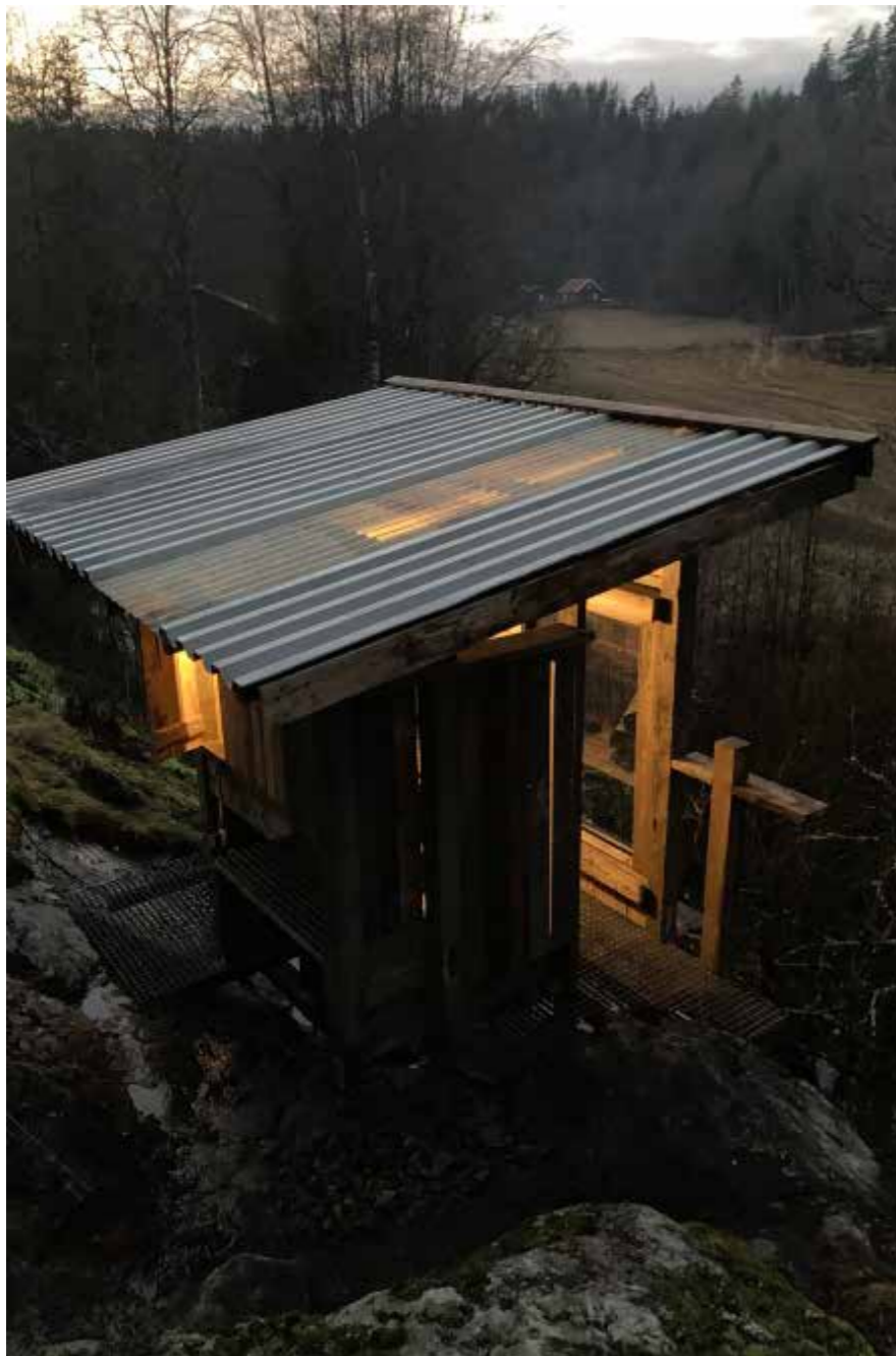
D09 - Tak D09 - Roof
