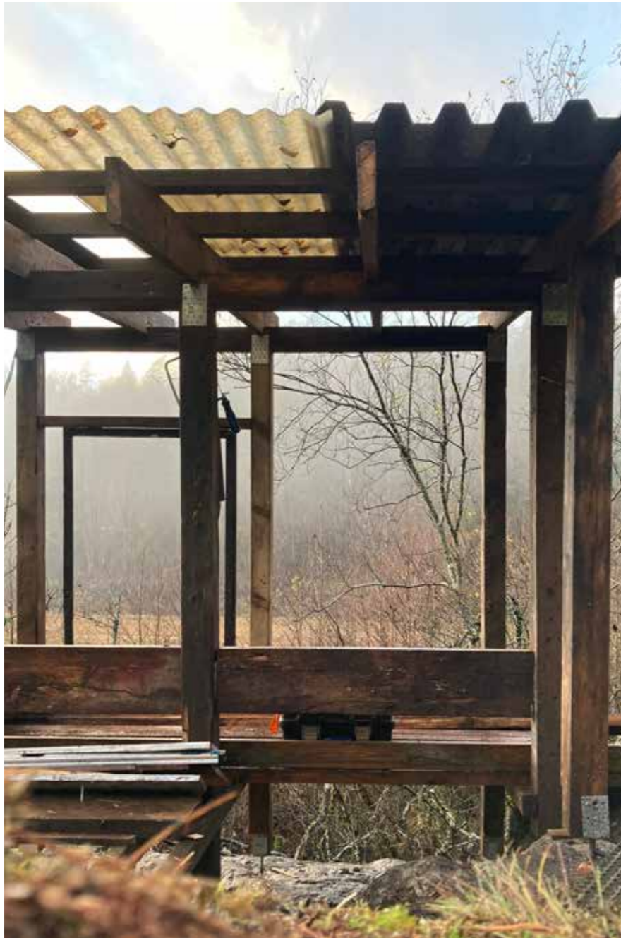
D09 - Tak D09 - Roof
