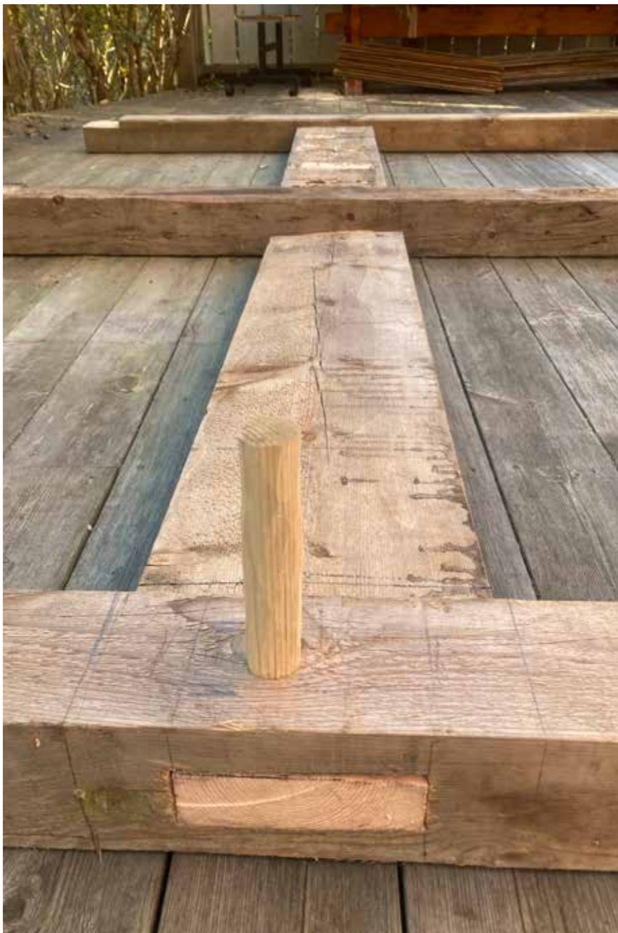
Bjlkene i rammene er felt inn i søylene med tapper og låst fast med en dybel.
