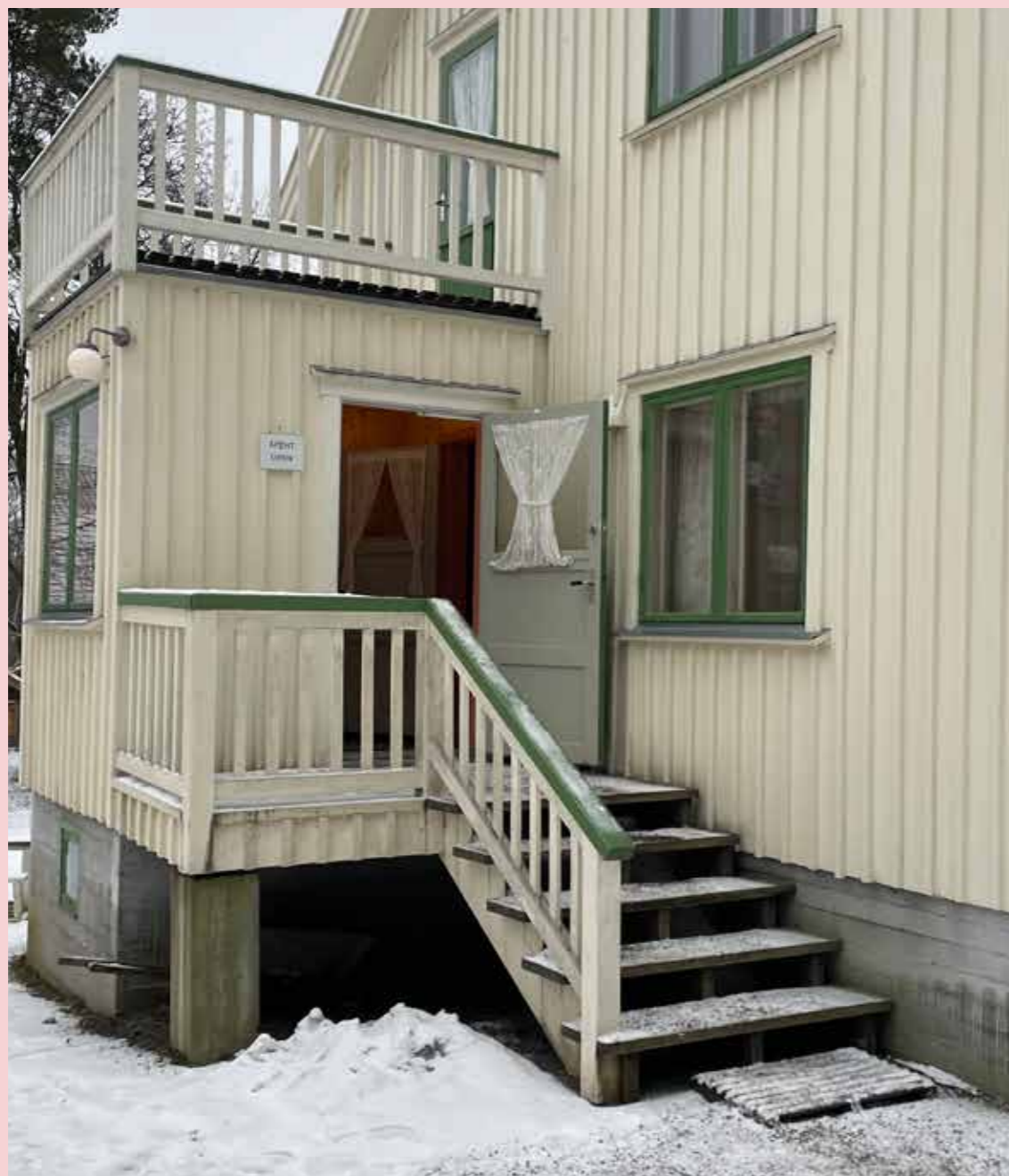
Inngangspartiet/vindfanget på huset. Nord-norge er en værhard landsdel hvor ett vindfang kan gi en bedre opplevelse av beveegelsen ut og inn av hus, her taket på vindfanget benyttet som luftteveranda, noe som også kan knyttes til funksjonalismen, man bruker arealet man har -og danner løsninger av det som å bruke innerom til uterom.
