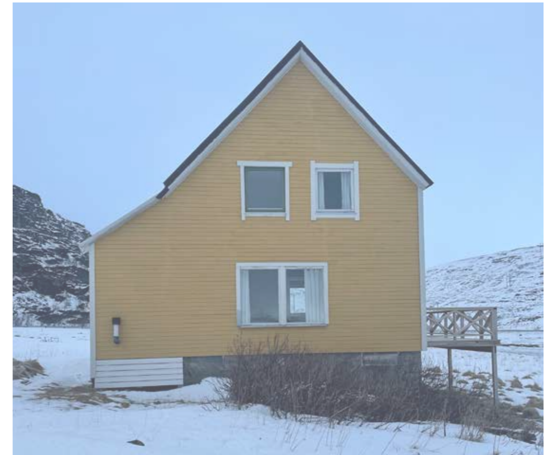
Huset på Sørøya er bygget i Sinklaft
