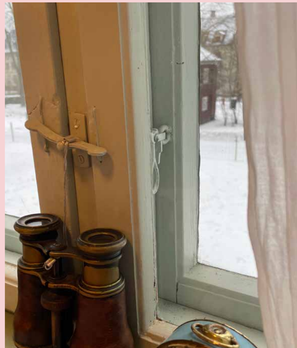
Nærbilde av vindusdetalj hvor det består av ett vindu som får ut og eett som går innover.
