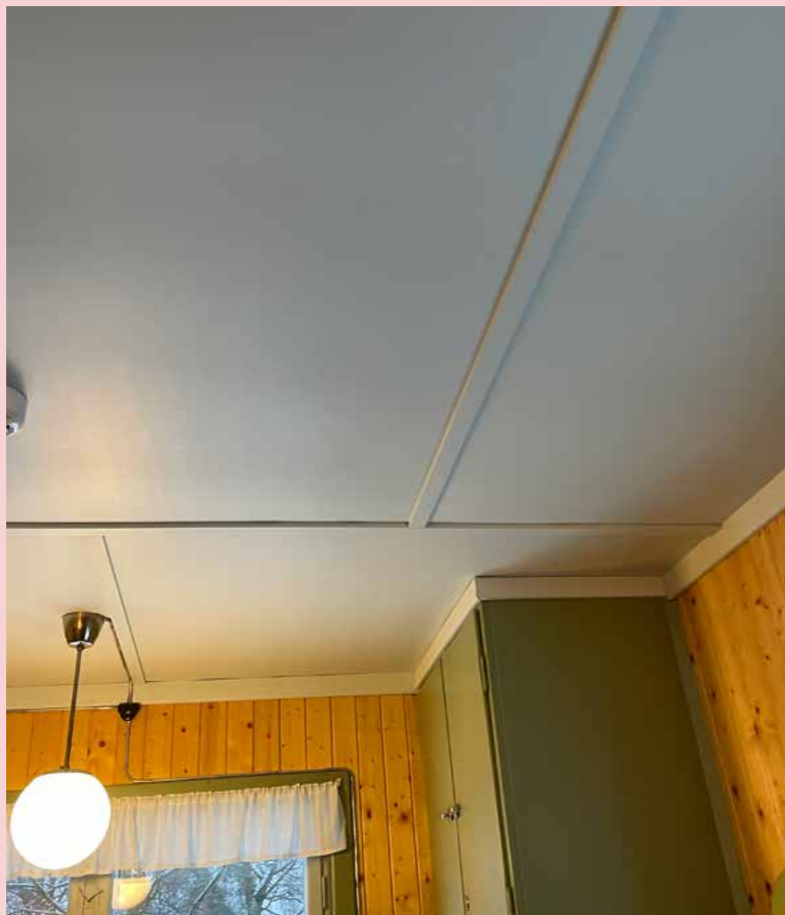
For å skjule skjøter ble det lagt lister i taket.
