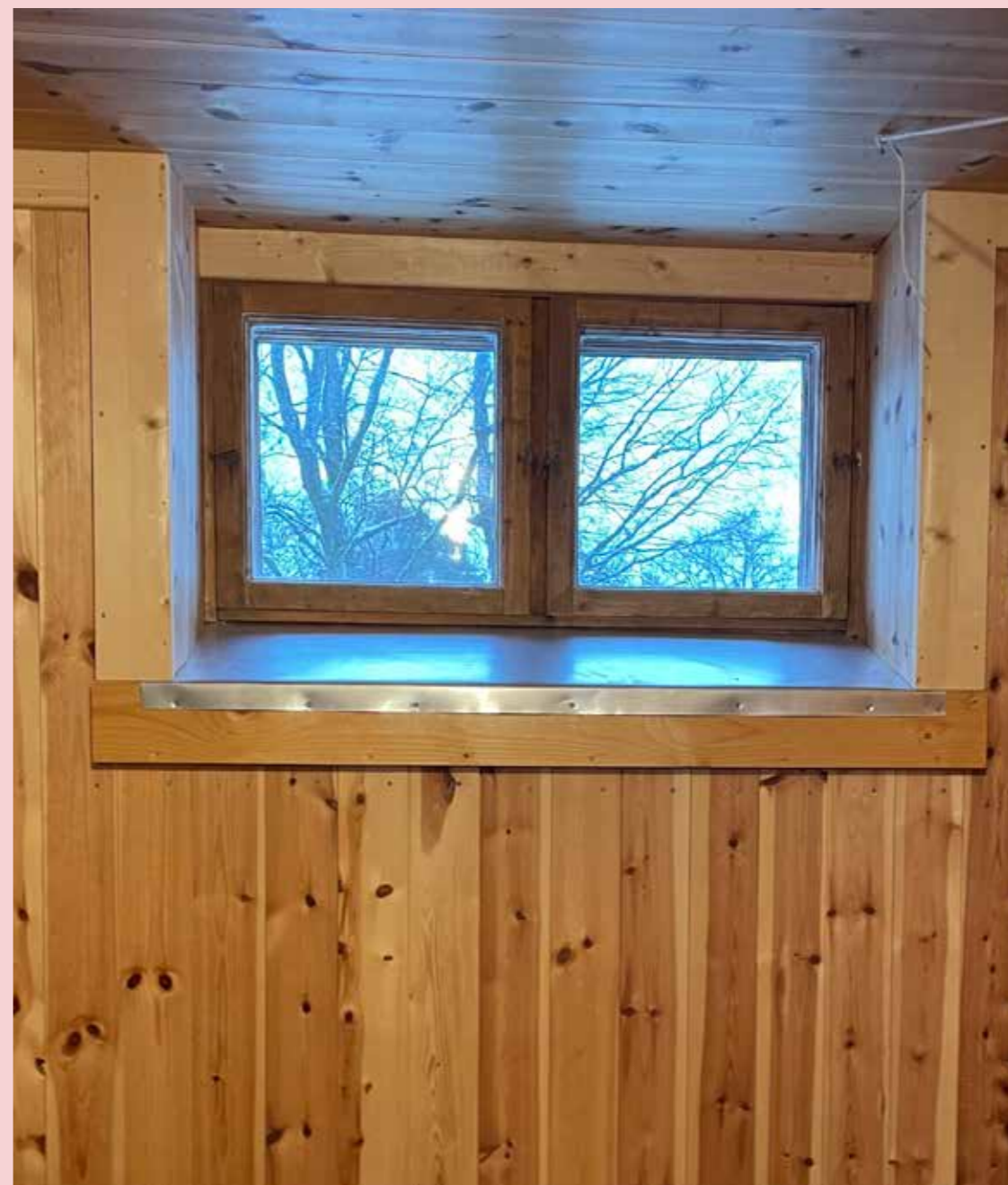
Nærbilde av ett kjellervindu
