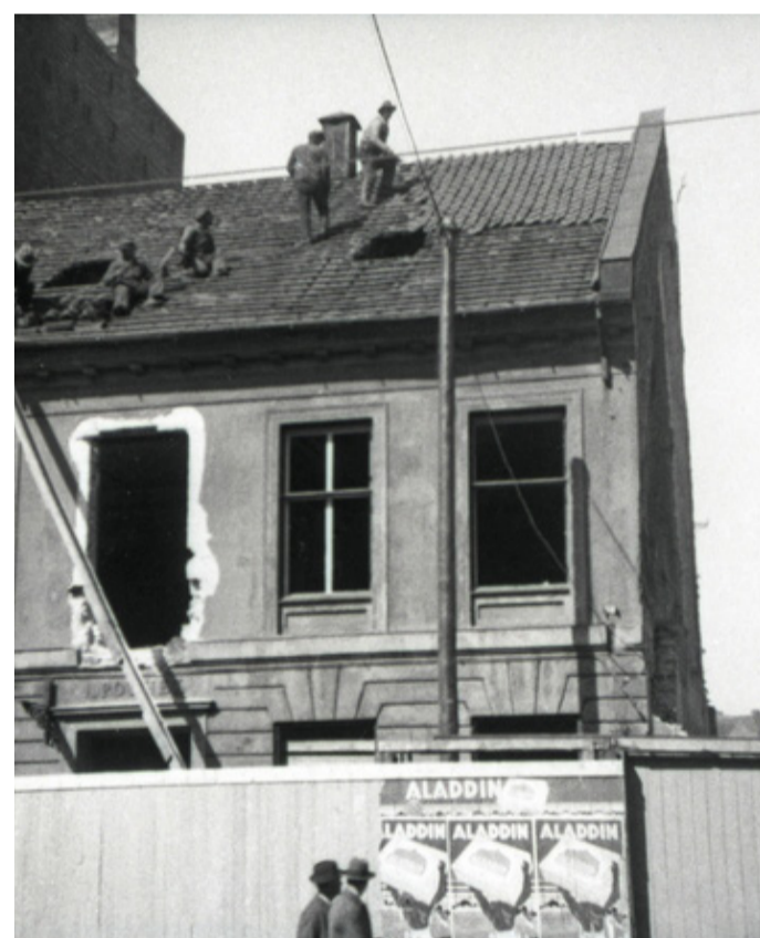
Demolishing Apotek Løven (Storgata 21) 1933
