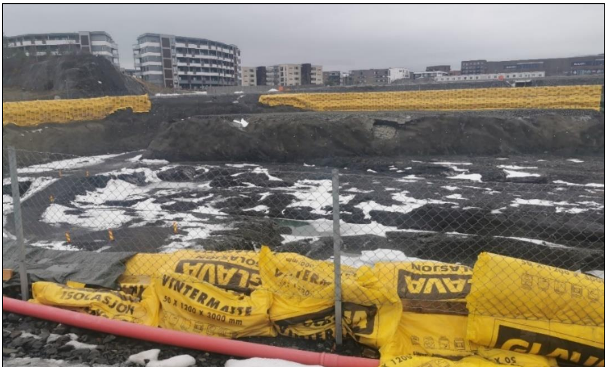
Figur 19: Byggegroppen på Fornebu (Foto: Ole Christian Tollersrud).
