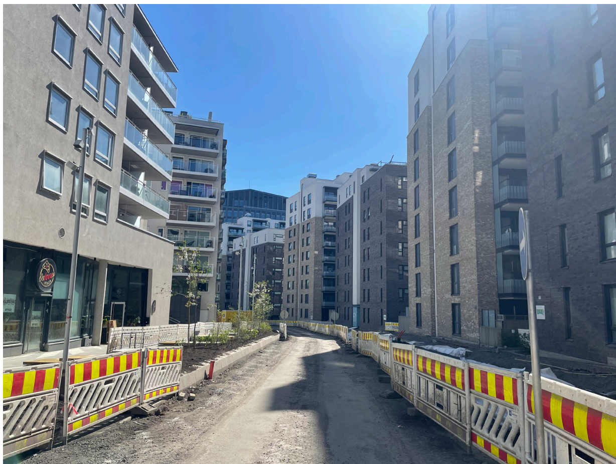
Figur 40 Lørenveien, sett fra vest - 03.04.2023
