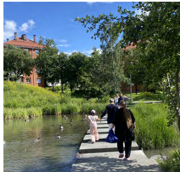
Bilde 3 Hovinbekken er gjenåpnet ved Teglverksdammen på Hasle i Oslo. Solide steinblokker er plassert på rekke, slik at man kan gå over bekken samtidig som vannet finner veien mellom steinene. (Foto: Tharan Fergus)
