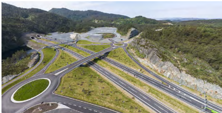
Bilde 2 E39 i Endelausmarka, med avkjøring mot Drange og Lysefjorden. Store deler av vannet Kvernatjørn ble fylt ut for å etablere veianlegget. (Dronefoto: Hawkeye AS)
