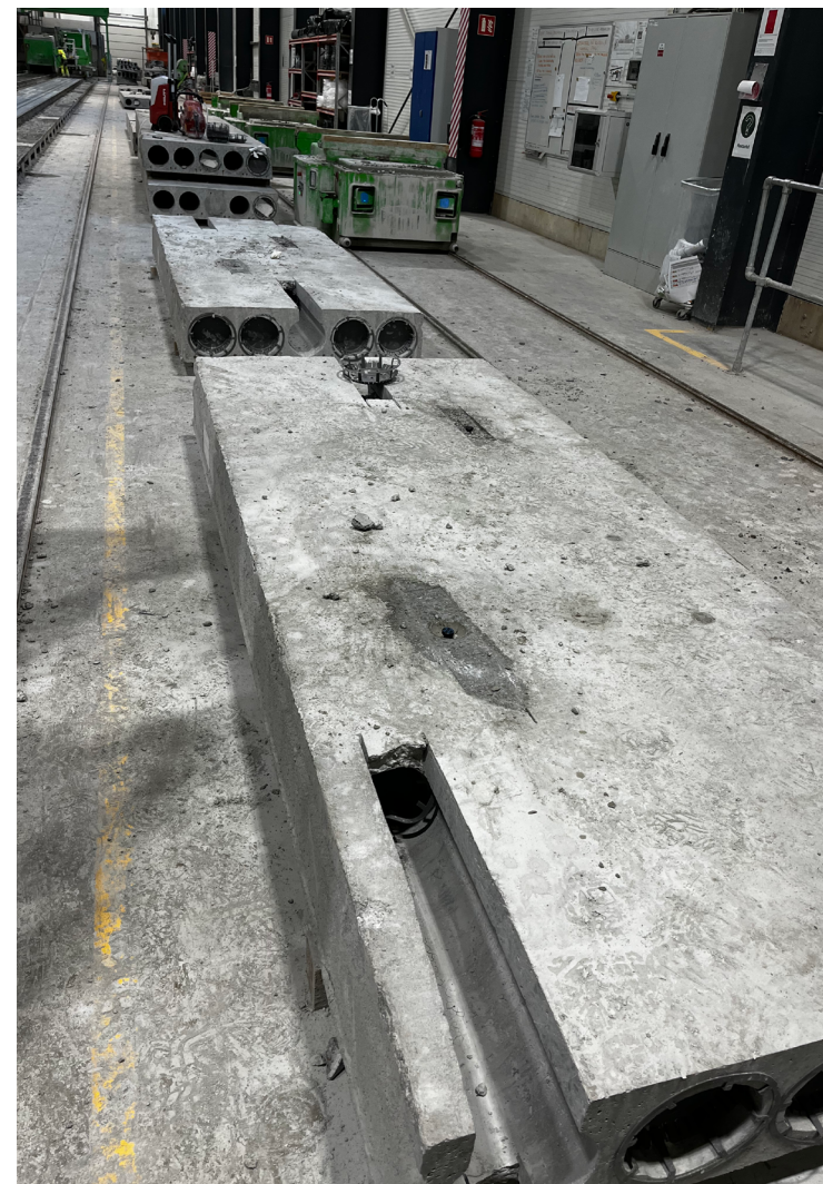
Bilde 3 Demonterte hulldekker fra Midtbygda sykehjem som Skanska skal remontere i nytt bygg. Gjenbruk av hulldekker har stort potensial for klimagassbesparelser – gjenbruk gir 90 prosent mindre klimagassutslipp enn bruk av nye hulldekker. I FOU-prosjektet SirkBygg, forsker Skanska, SINTEF, Contiga og Spenncon frem metoder for å gjøre gjenbruk mer rasjonelt. Prosjektet har bidratt til en ny ombruksstandard (Norsk Standard NS3682) for hulldekelementer, og til lavere priser. (Foto: Skanska Norge AS)
