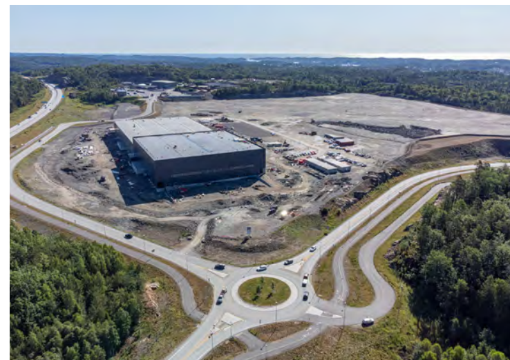
Bilde 2 Morrow Batteries i Arendal. Første byggetrinn – pilotanlegget – åpnet i 2024. Tomten er tilrettelagt for videre utbygging av fabrikk. Den er planlagt fullt utbygd i 2028. (Foto: ©Morrow Batteries / Exyte)
